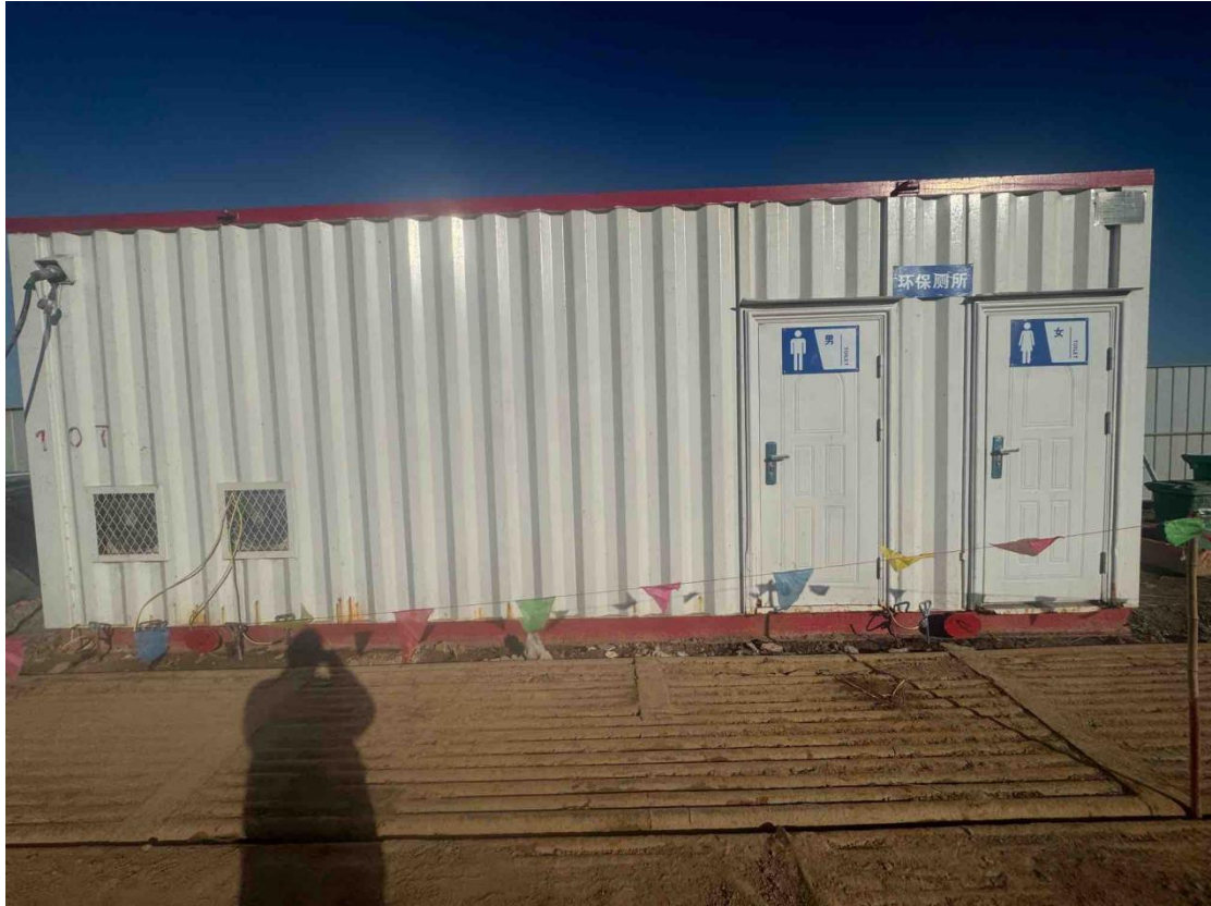
图 2-12 施工现场环保厕所照片
