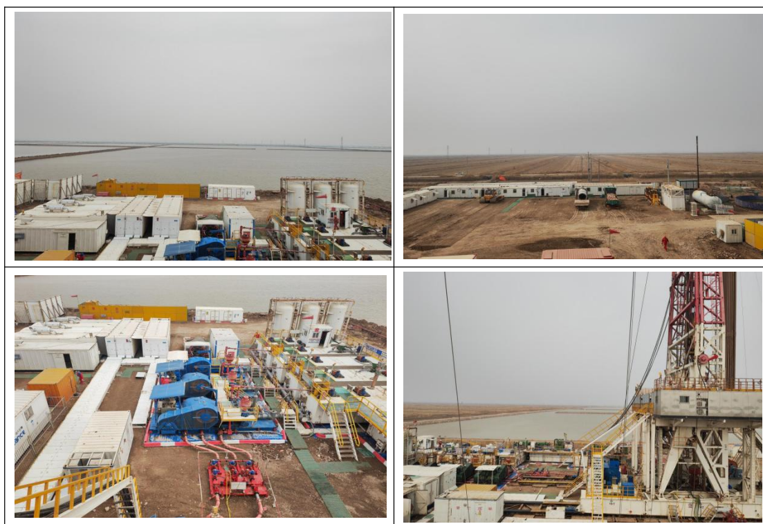
图 2-1 项目施工期现场照片
