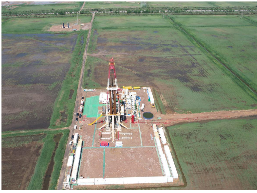
图 2-1 项目施工期照片
