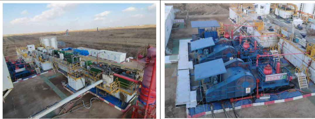
图 2-1 项目施工期现场照片
