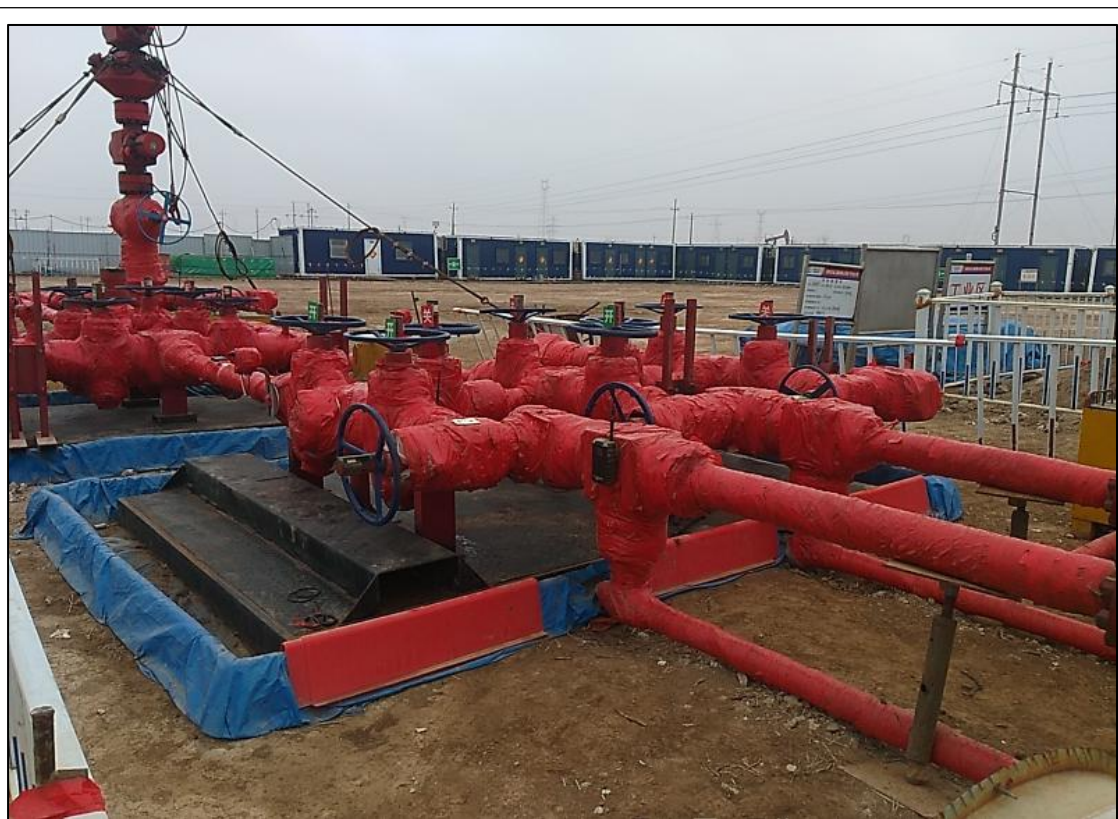
图 4-2 项目防渗措施现场照片
