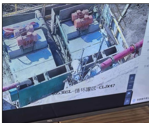
图 2-11 “泥浆不落地”照片
