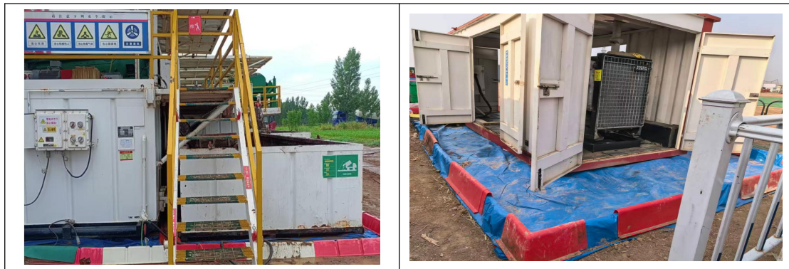
图 4-2 项目防渗照片
