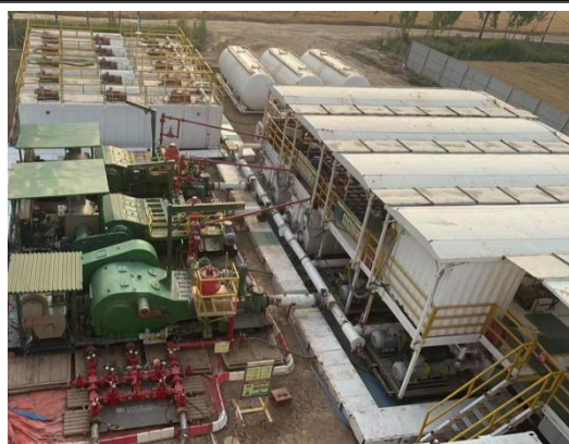
高斜 863 井场泥浆循环罐区
