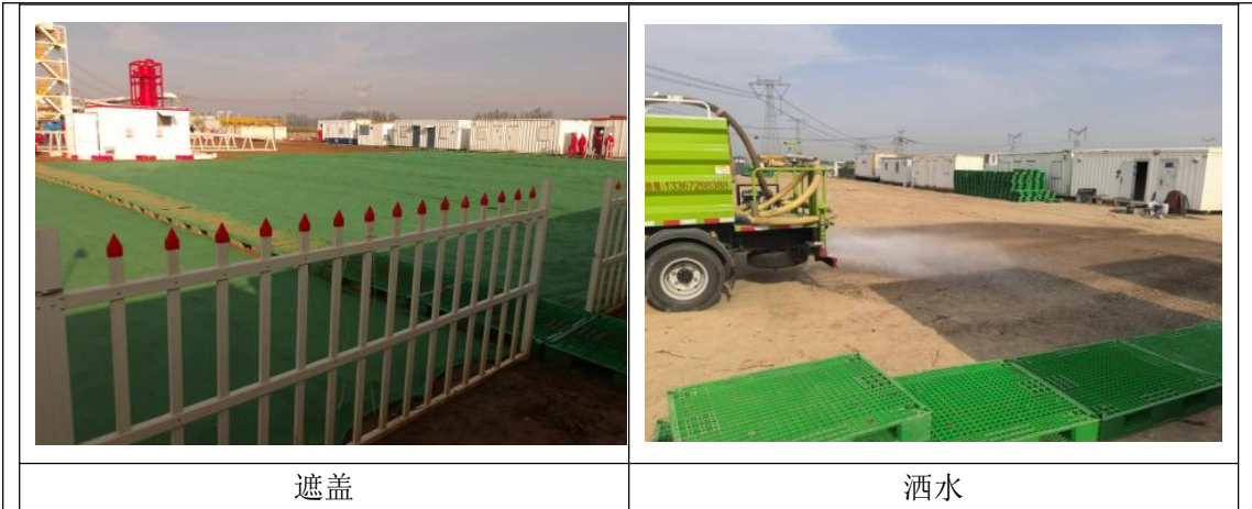
图 2-9 施工现场防尘措施
