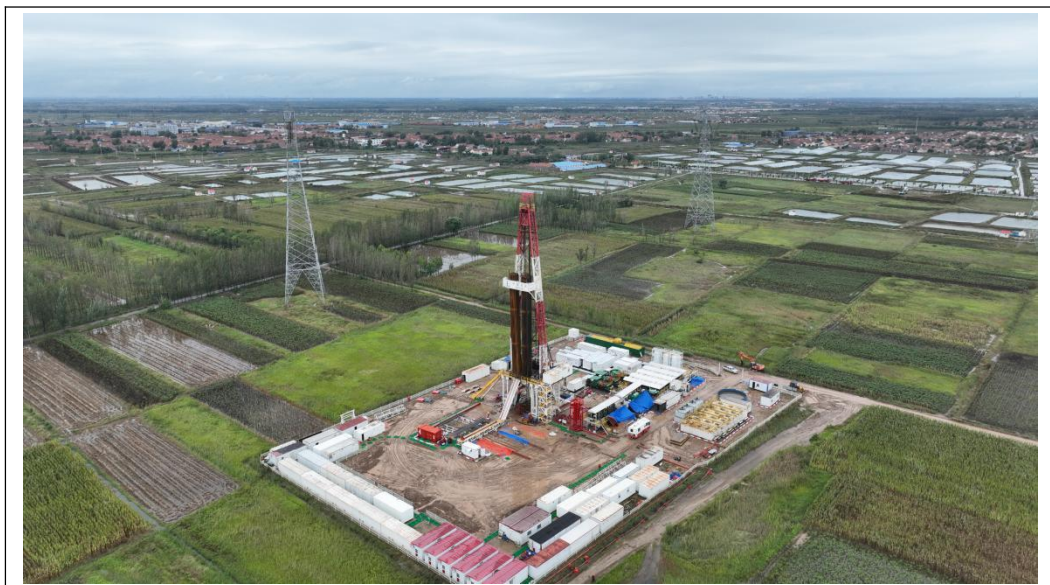
图 2-1 项目施工期照片
