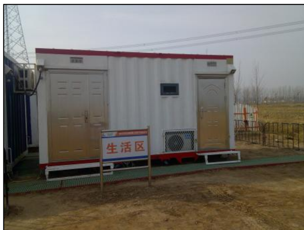
图 2-9 施工现场环保厕所照片
