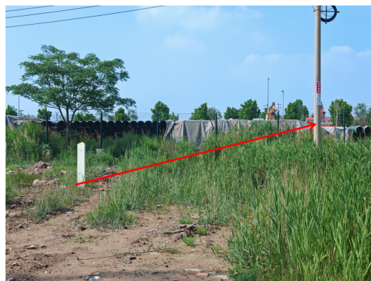
3819 阀组至坨二联集油干线优化改造定向钻穿越胜坨路入土点
