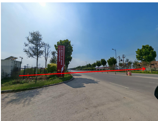
3819 阀组至坨二联集油干线优化改造定向钻穿越胜坨路
