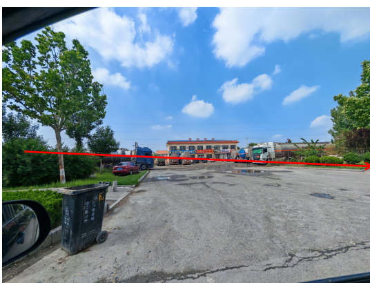
顶管穿越公路
