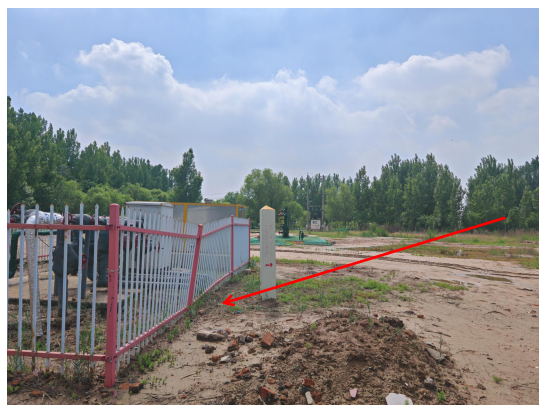
管理六区东部集油支干线优化改造 T149X10 阀组至 T142X45 阀组定向钻穿越二支渠等出土点
