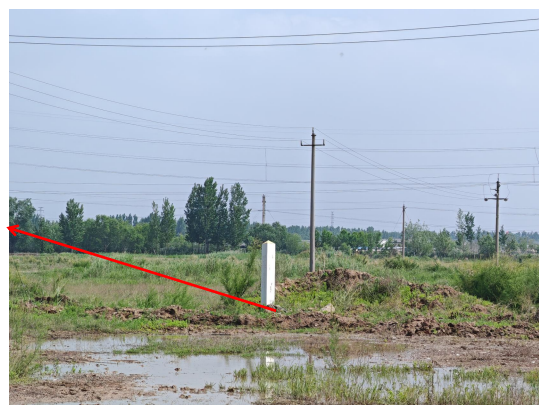
S 管理六区东部集油支干线优化改造 T149X10 阀组至 T142X45 阀组定向钻穿越二支渠等入土点
