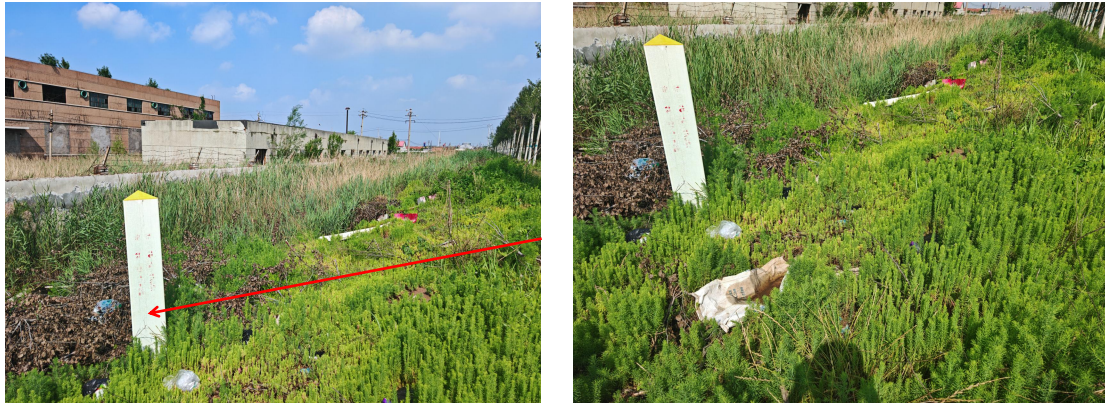
3819 阀组至坨二联集油干线优化改造定向钻 穿越胜坨路出土点
