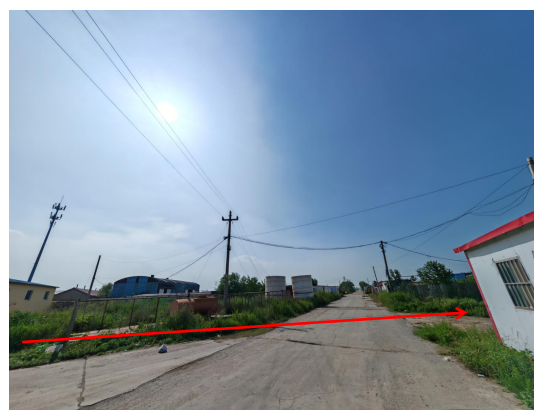
ST3-7X278 单井集油管线顶管穿越西四路
