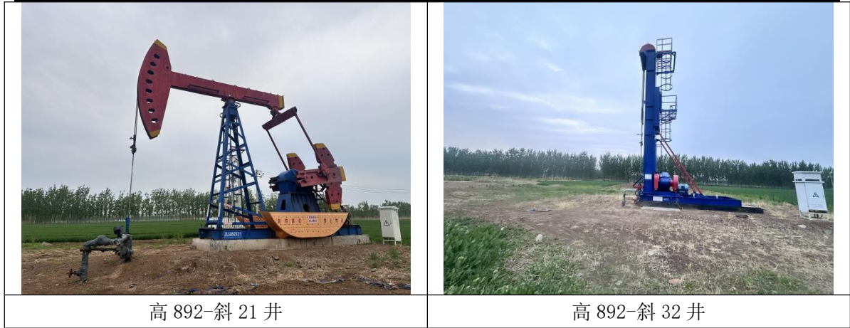
图 2-3 本项目油井、注水井现状照片
