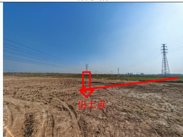
注水管线：2#井台定向钻穿越至利 93-斜 59 井场的 出土点
