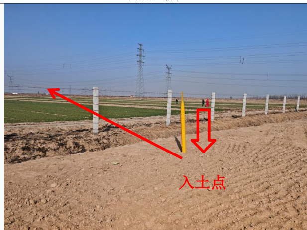
注水管线：2#井台定向钻穿越至利 93-斜 59 井场的 入土点
