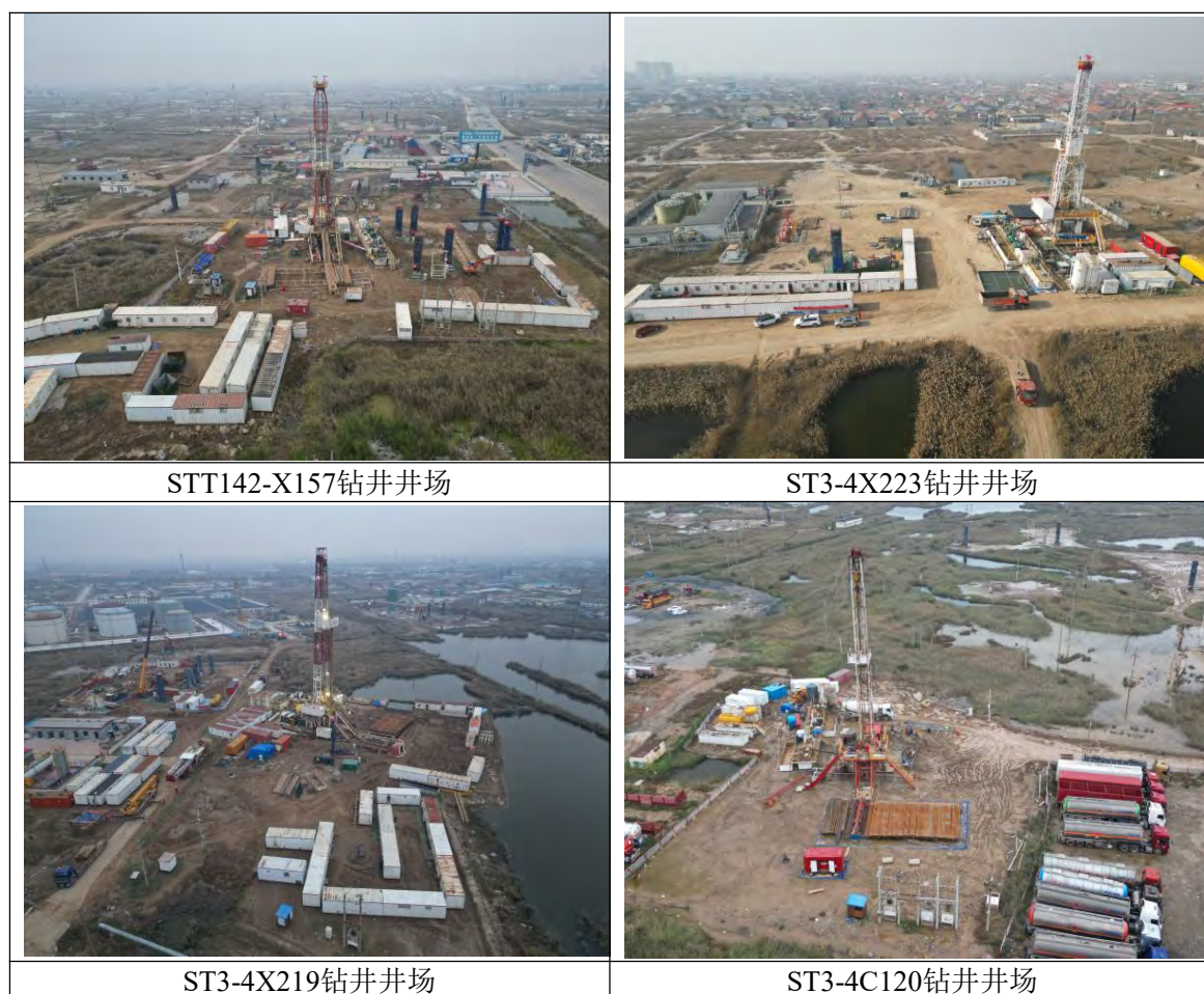
图3.3-2 钻井施工现场照片
