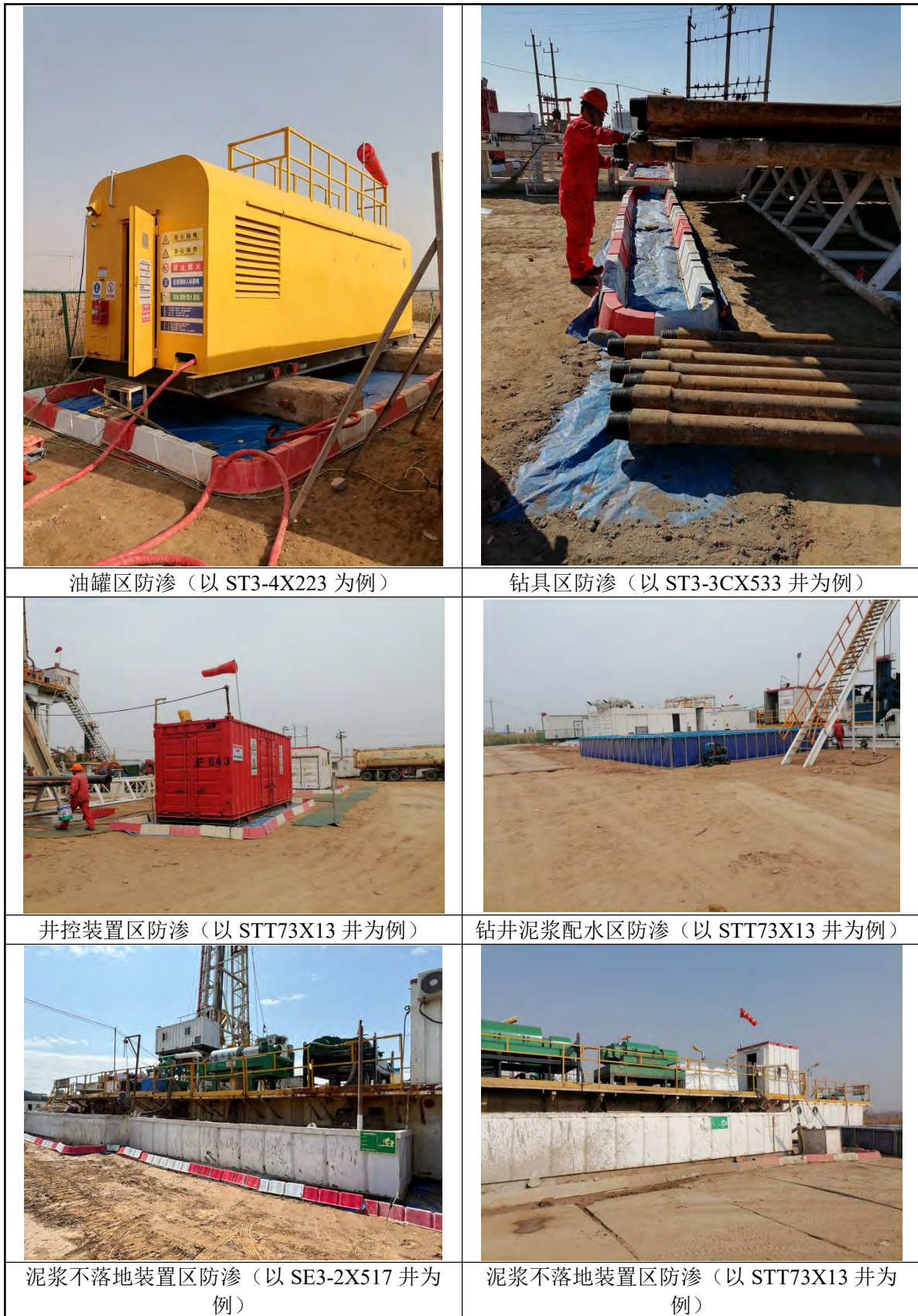
图5.1-1 本期工程防渗措施照片
