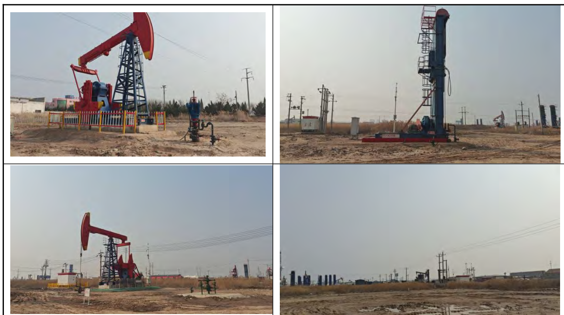
图5.1-2 本期工程周边生态及井场现状
