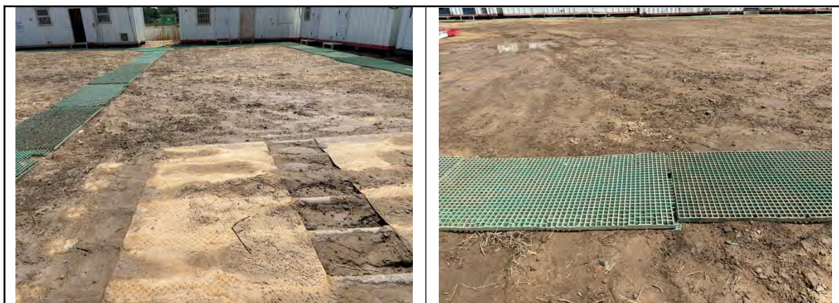
图 5.2-1 本期工程施工扬尘防治措施
