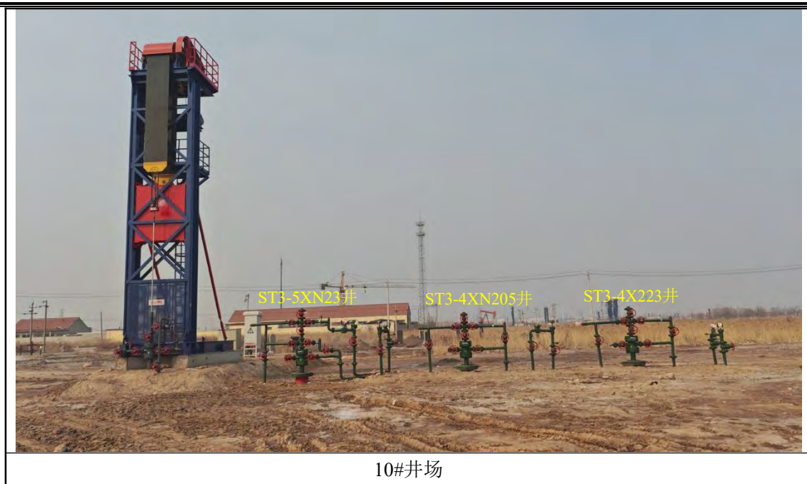
图3.3-6 本期工程注水井现场照片
