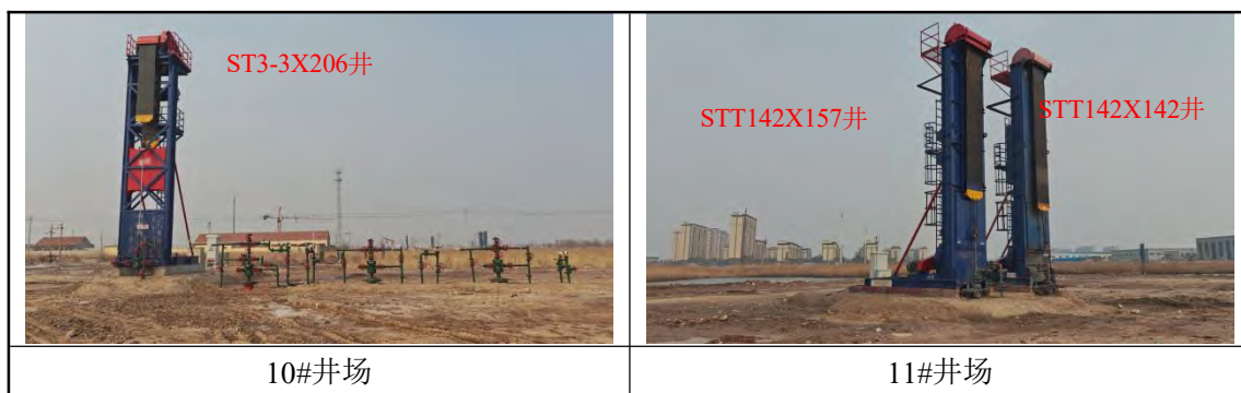
图3.3-3 本期工程油井现场照片
