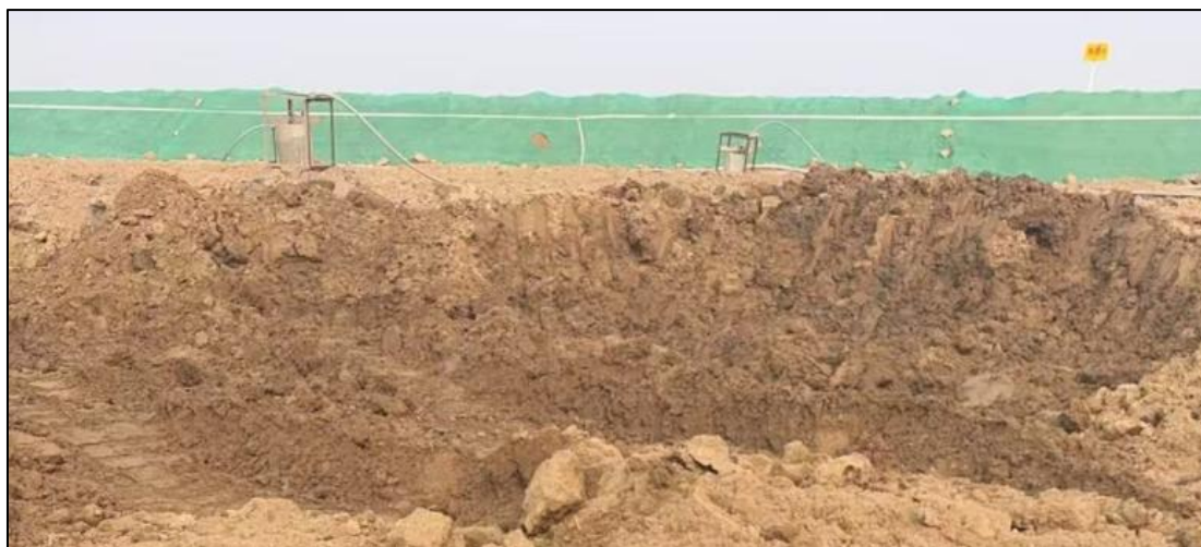
图 3.5-1 施工期遮盖措施抑尘现场照片
