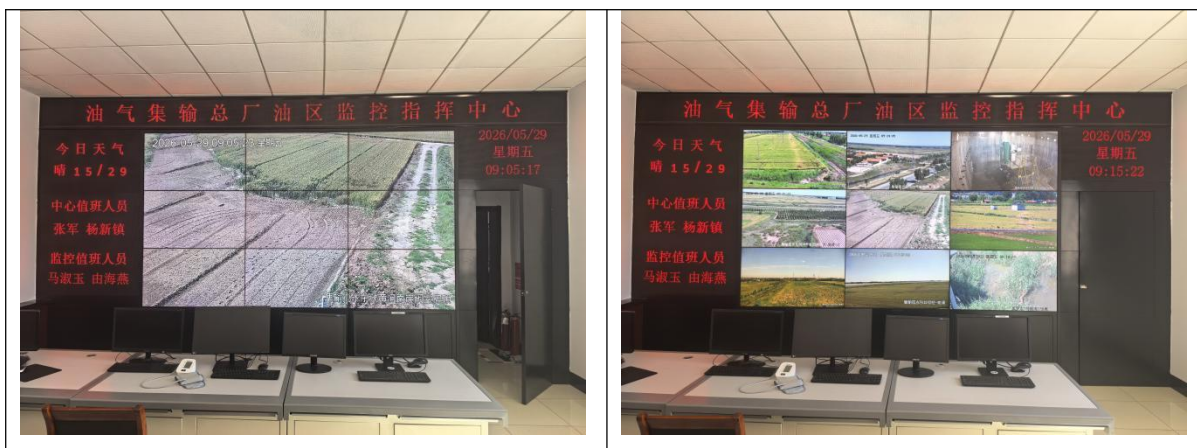
图5.3-1 管线监控系统
