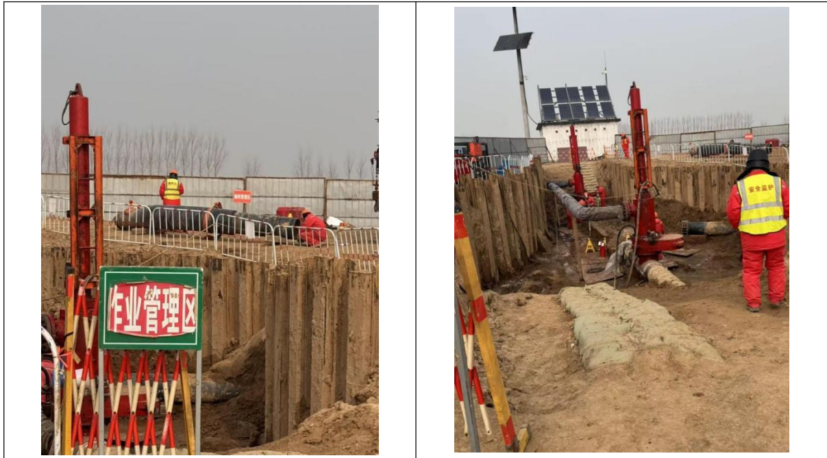
图3.3-6 管线封堵现场施工照片
