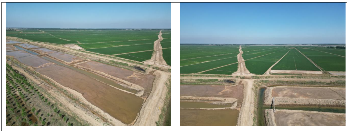
图5.1-1 管线周边生态恢复照片
