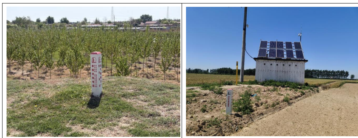
图3.2-5 管线标志桩现场照片
