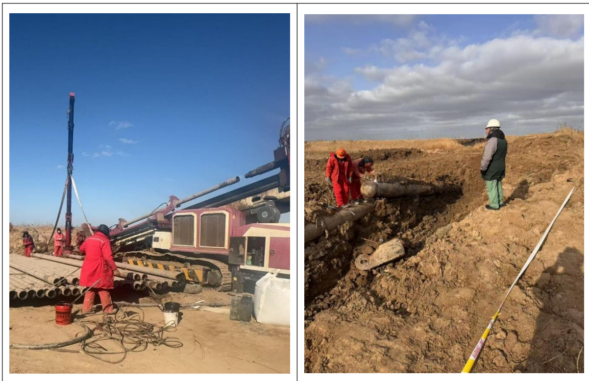
图3.3-5 定向钻现场施工照片
