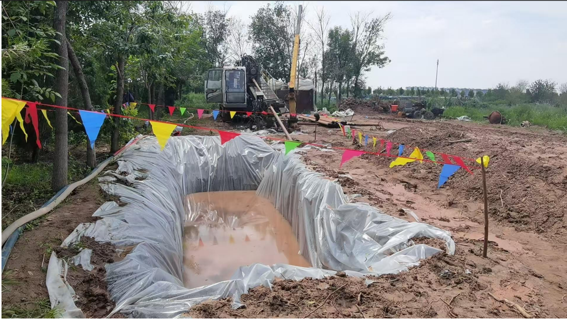
图 5.1-2 施工期泥浆坑
