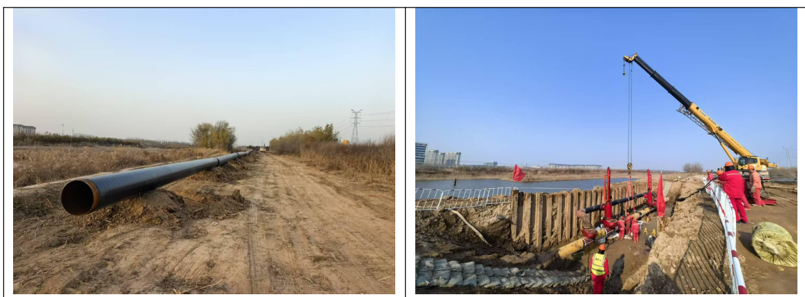
图 3.4-1 施工期现场照片
