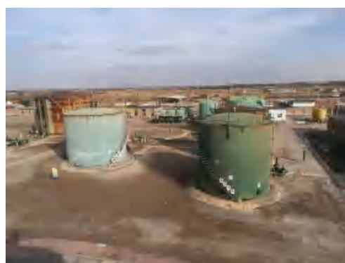
垦西联合站采出水处理系统
