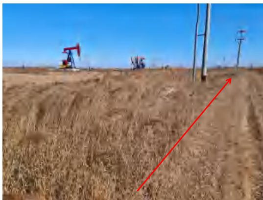
管线开挖后生态恢复情况
