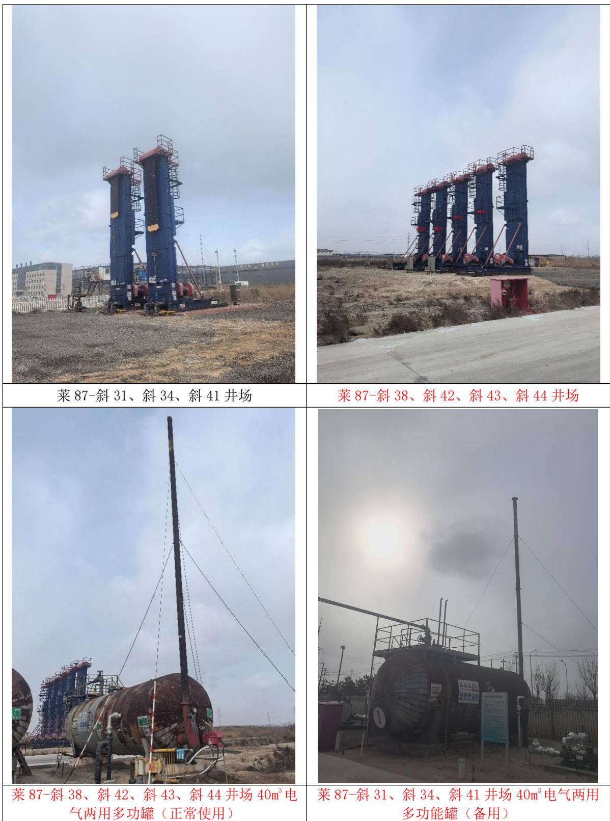
图 3.2-2 本项目主要建设设施现状照片
