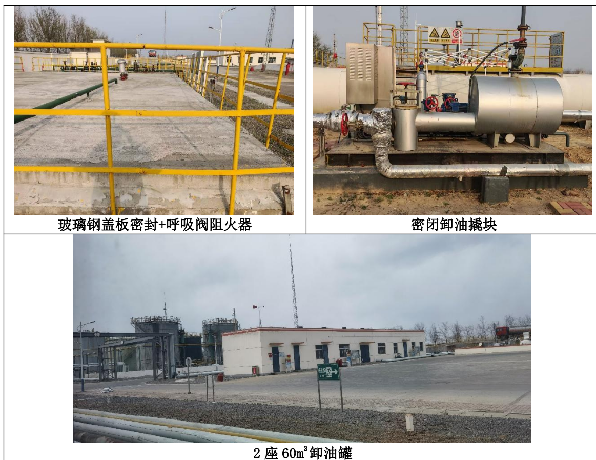
图 3.1-1 现有工程整改情况现状图
