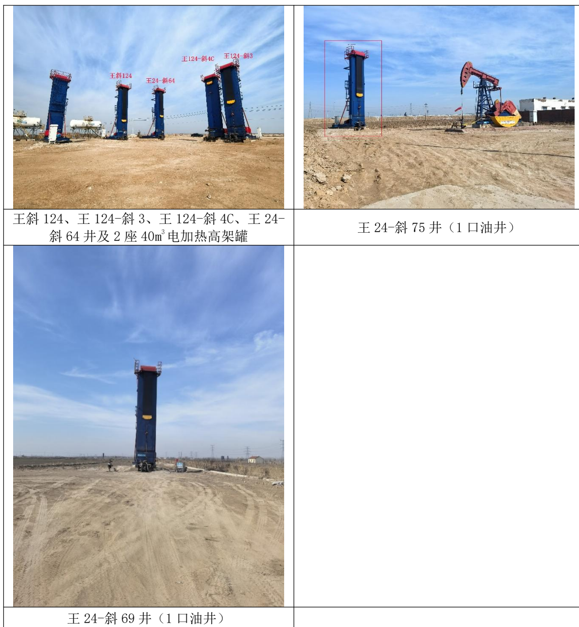
图 3.2- 2 项目一期部署井及配套生产设备现状图
