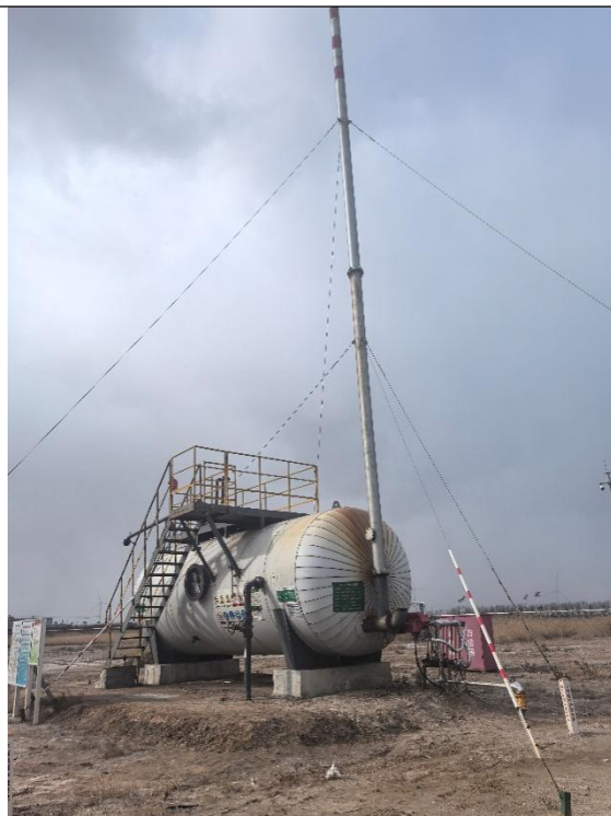
莱 87-斜 26 井场新建的 1 座多功能罐
