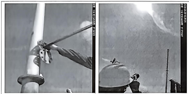
附图 1: 现场检测照片
