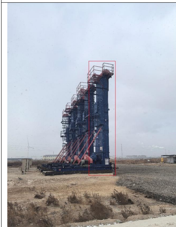
莱 87-斜 45 井（1 口油井）
