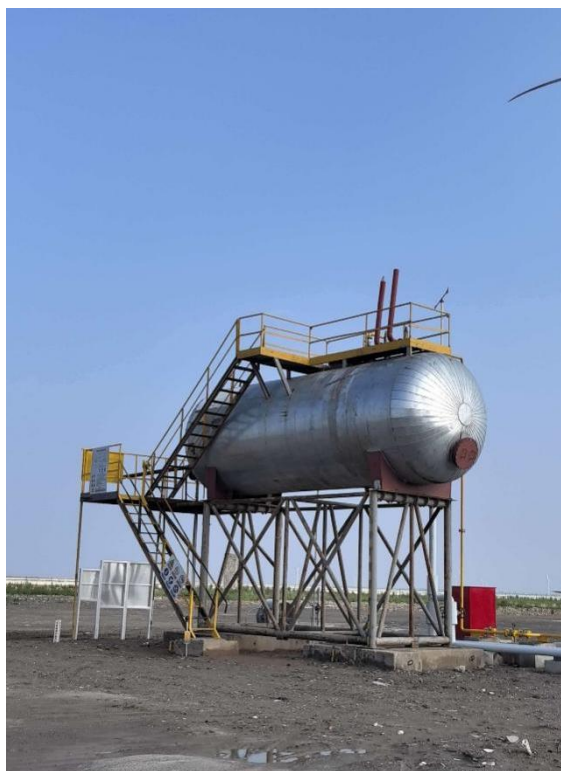
莱 87-斜 19、斜 46、斜 48、斜 56C 井场新建的 1 座 40m 3 电加热高架罐
