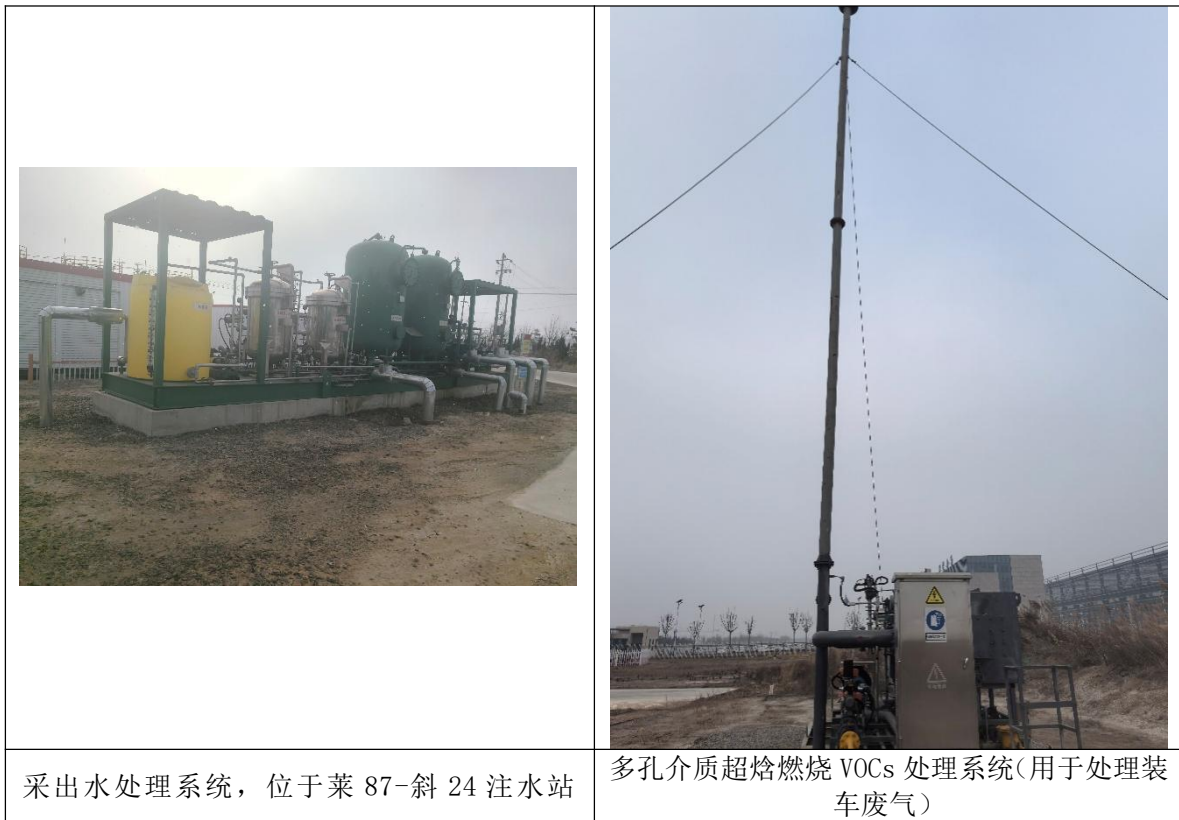
图 3.2- 11 项目一期站场工程现场照片
