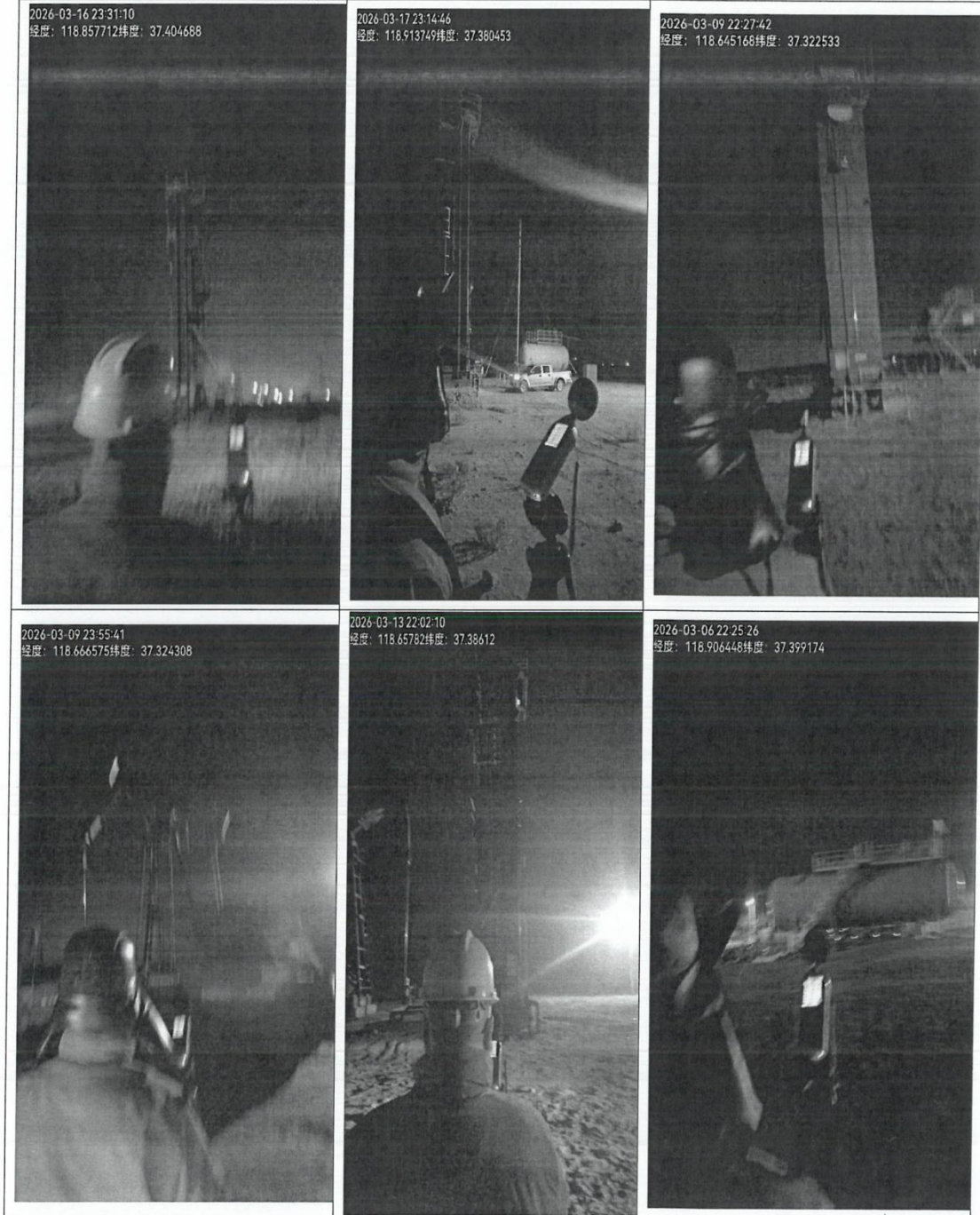
附图 7: 现场检测照片
