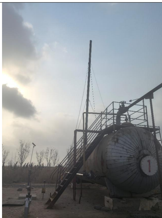
莱 78-斜 15、斜 16 井场新建的 1 座多功能罐
