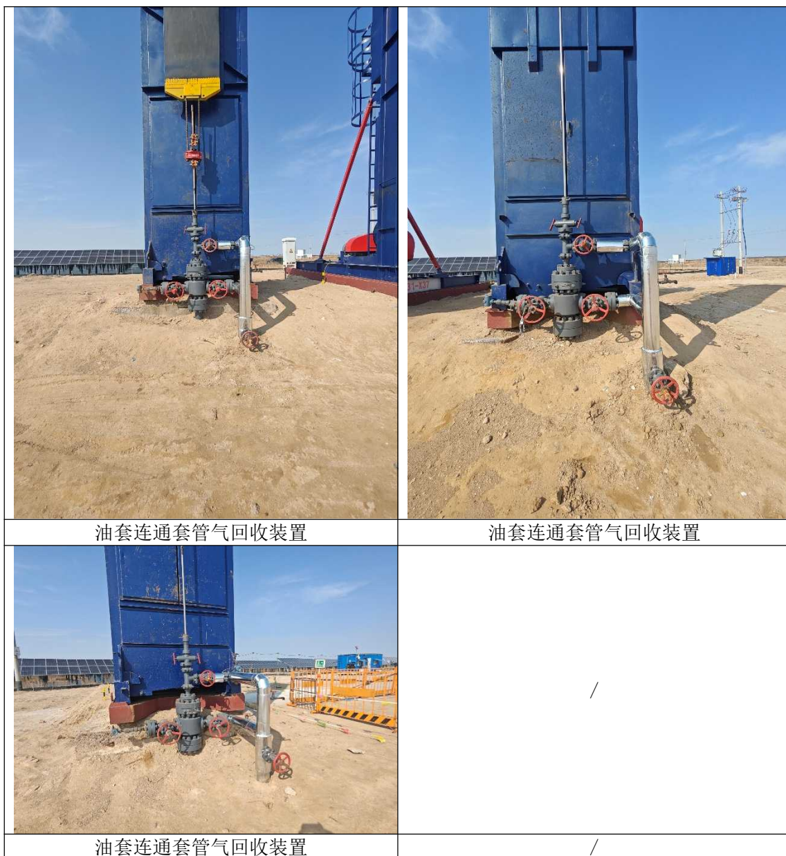
图 5.2-1 废气污染防治和处置措施现场照片
