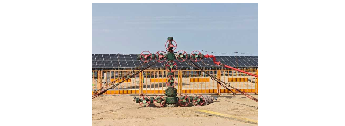
图 3.3-6 项目注水井现场照片
