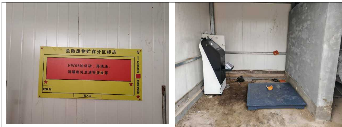
图 3.3-12 B3-斜 66 井场危废暂存间设置情况
