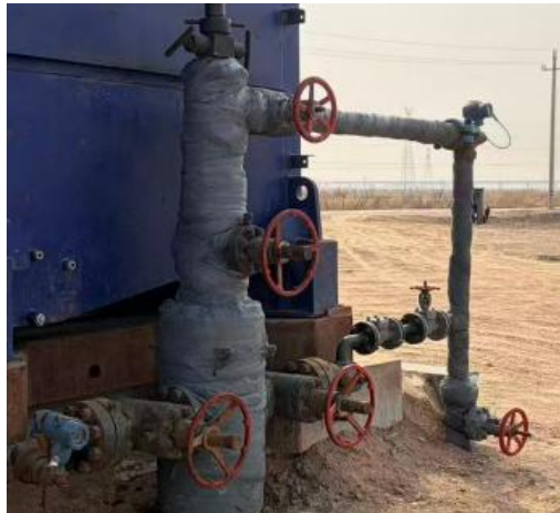
图 3.3-2 油套连通装置
