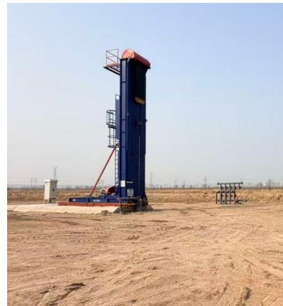
井场碾压平整情况
