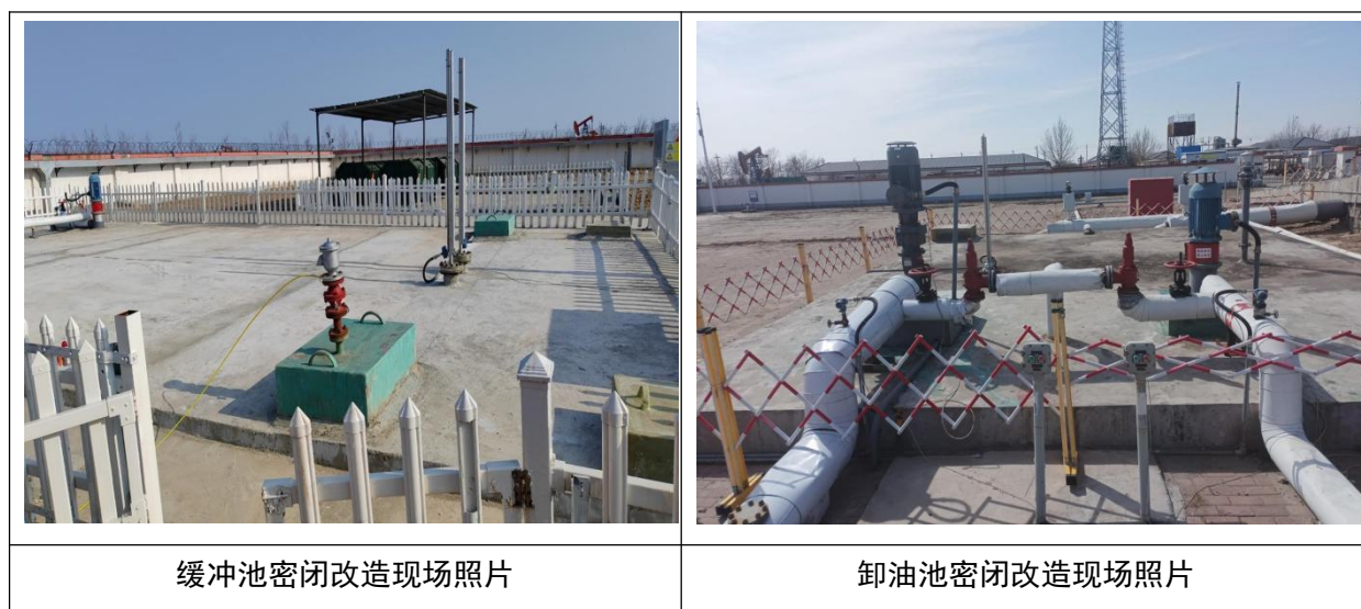
图 3-2 现场整改照片
