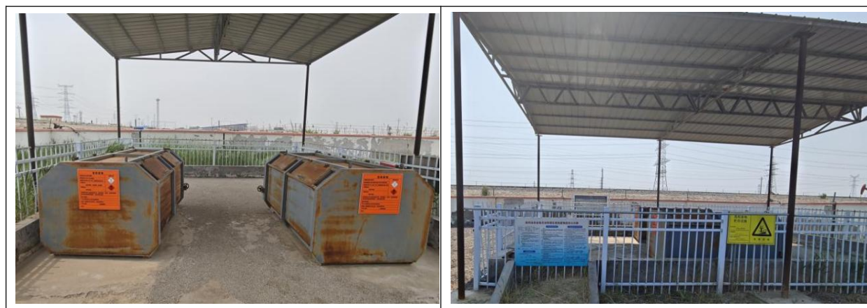
图 3-14 桩 23-11-11 危废暂存点现场照片
