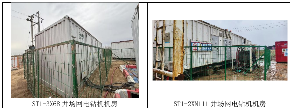
图 3-15 网电钻井现场照片
