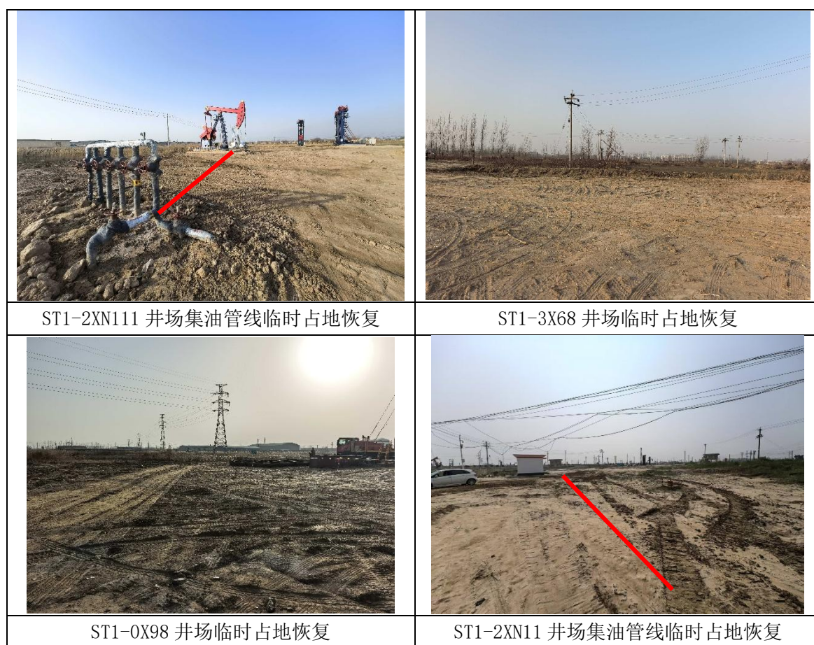
图 5-2 本工程临时占地恢复地貌和植被情况
