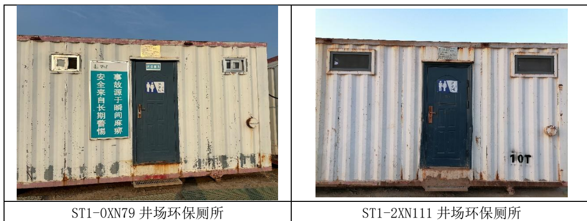
图 5-3 施工期间环保厕所现场照片
