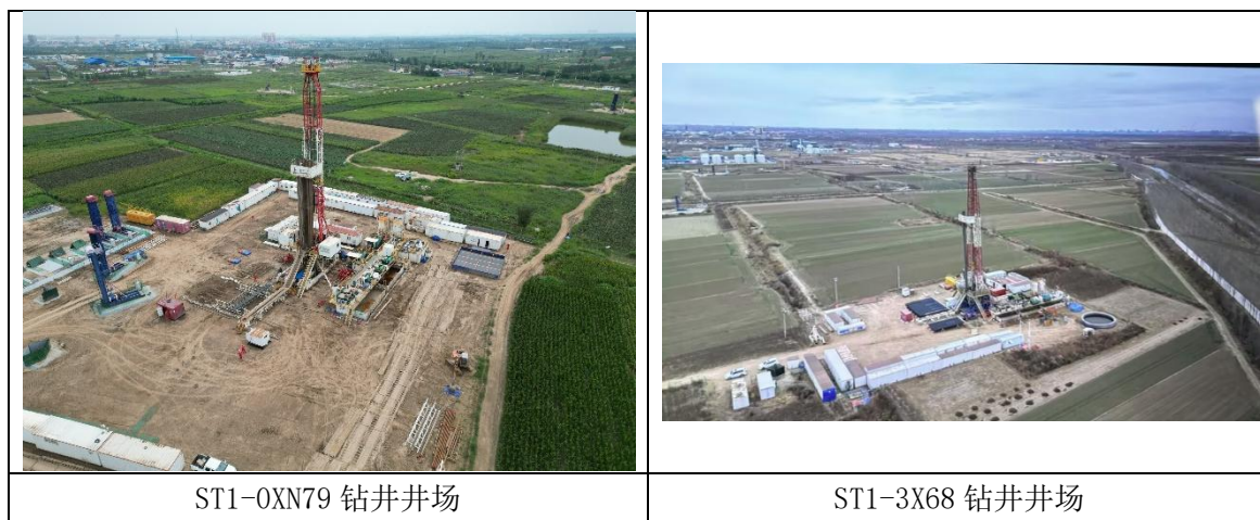
图 5-1 本项目施工期井场占地情况
