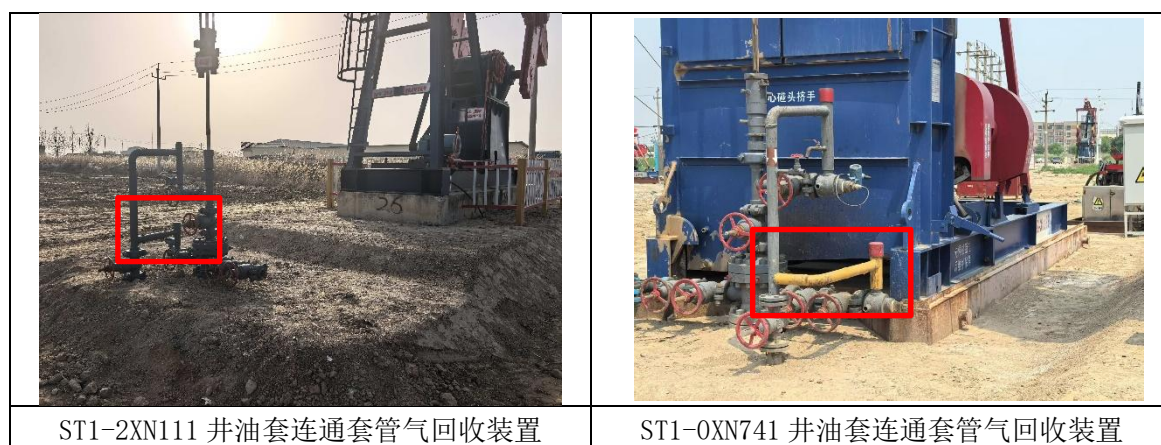
图 5-6 废气污染防治设备现场照片
