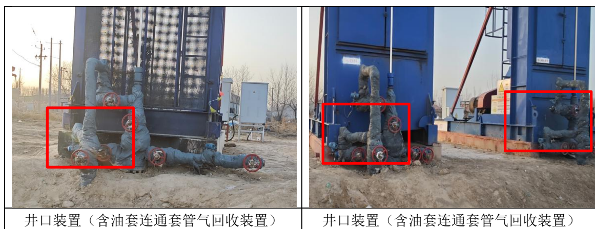
图 5-4 油套连通套管气回收装置现场照片
