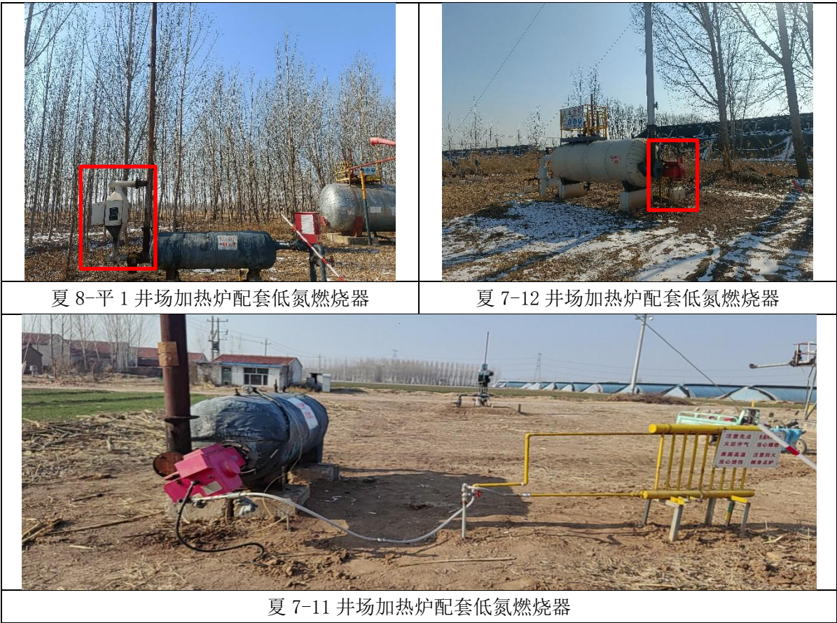
图 5.2-1 加热炉低氮燃烧器现场照片
