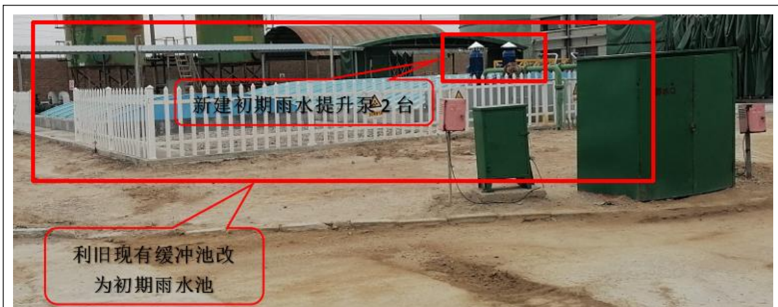
雨水池改造及新建雨水提升泵
