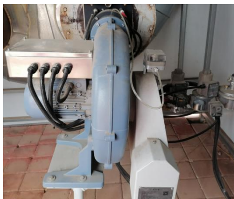
低氮燃烧器及废气标识牌
