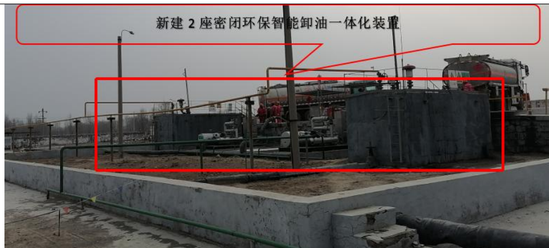
新建密闭环环保智能卸油一体化装置
