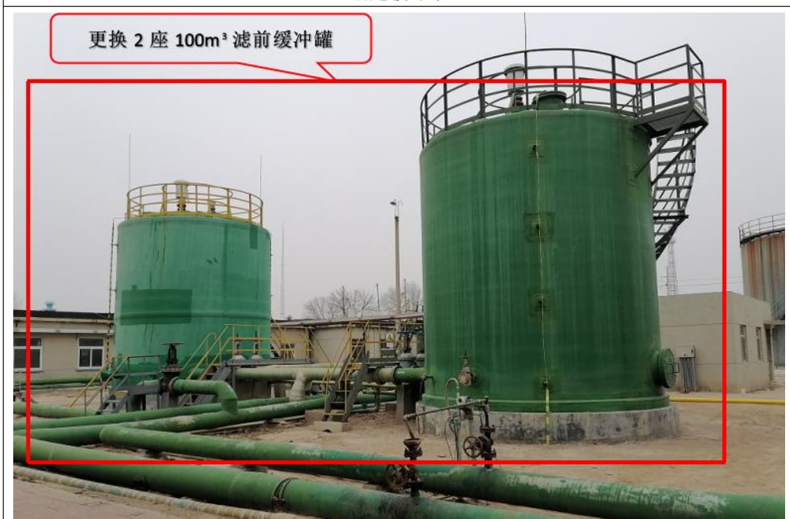
更换 2 座 100m³ 滤前缓冲罐
