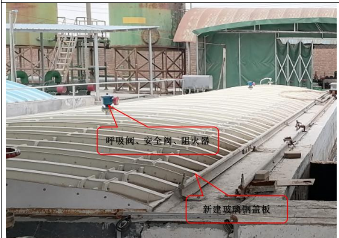
调剖池加装玻璃钢盖板及呼吸阀、安全阀、阻火器
