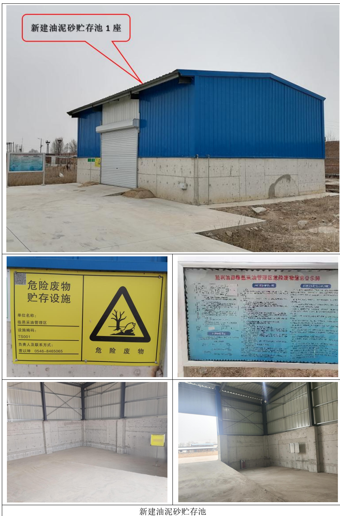
图 3.2-1 项目主要工程现场照片（改造后）
