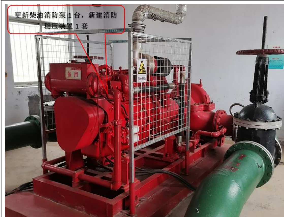
更新柴油消防泵 1 台，新建消防稳压装置 1 套
