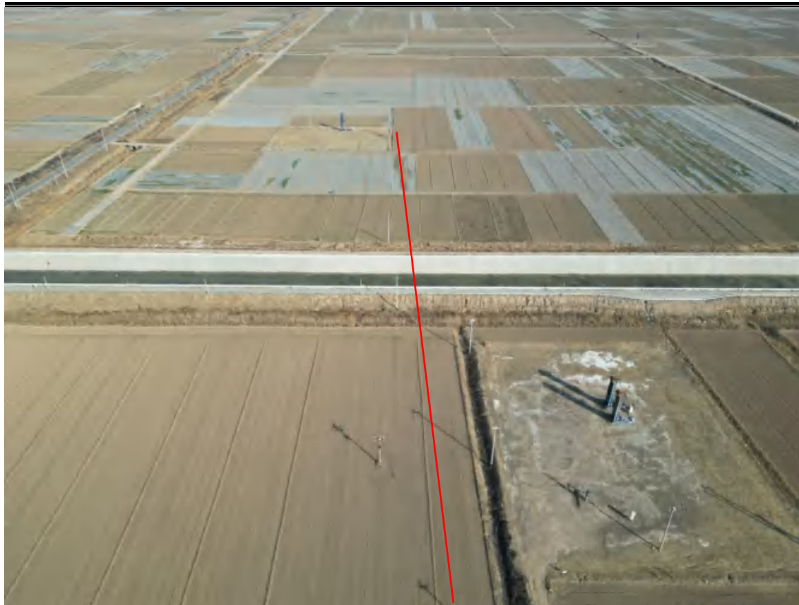
图 3.3-12 项目管线穿跨越（大坝）照片
