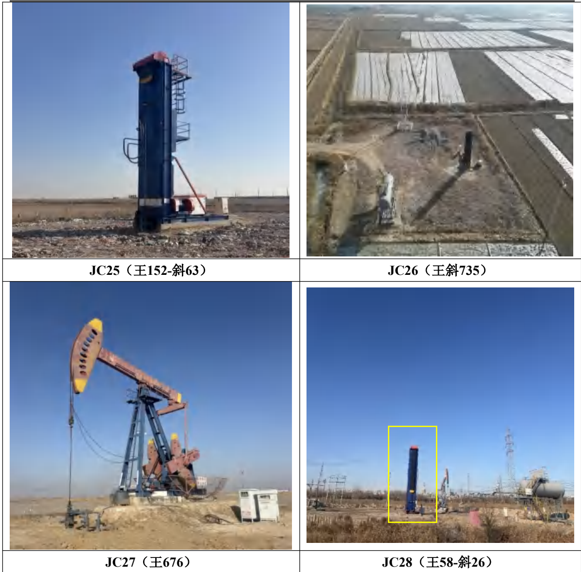
图 3.3-1 本期工程部分井场采油设备现场照片
