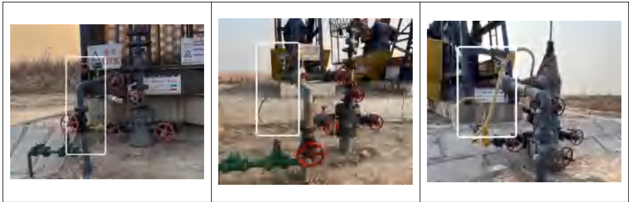
图 5.2-1 油套连通装置照片（部分）
