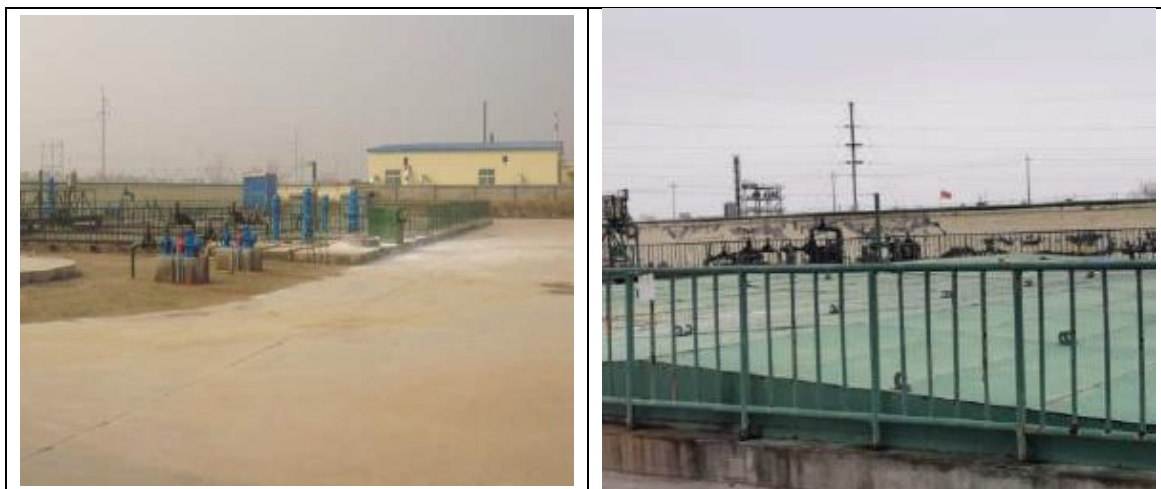
图 4.2-3 永一联合站站场现状照片
