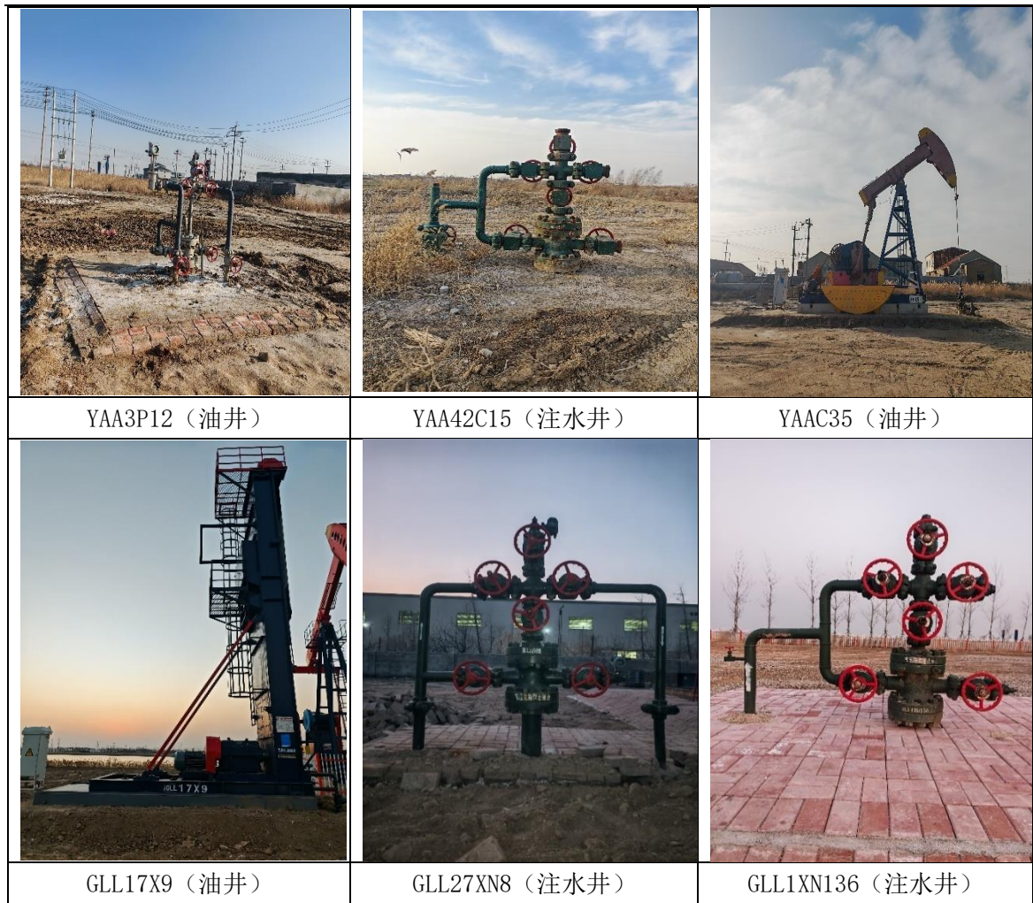
图 2.3-7 本期工程油井、注水井现状照片
