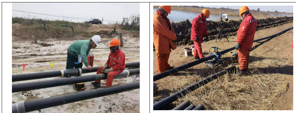
图 5-3 热收缩套防腐作业
