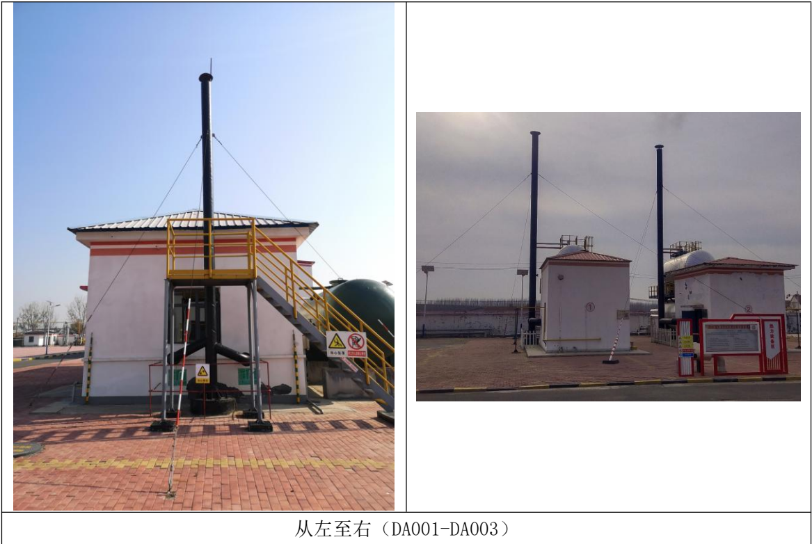
图 5 油气集输总厂集贤输油站排气筒监测点位照片
