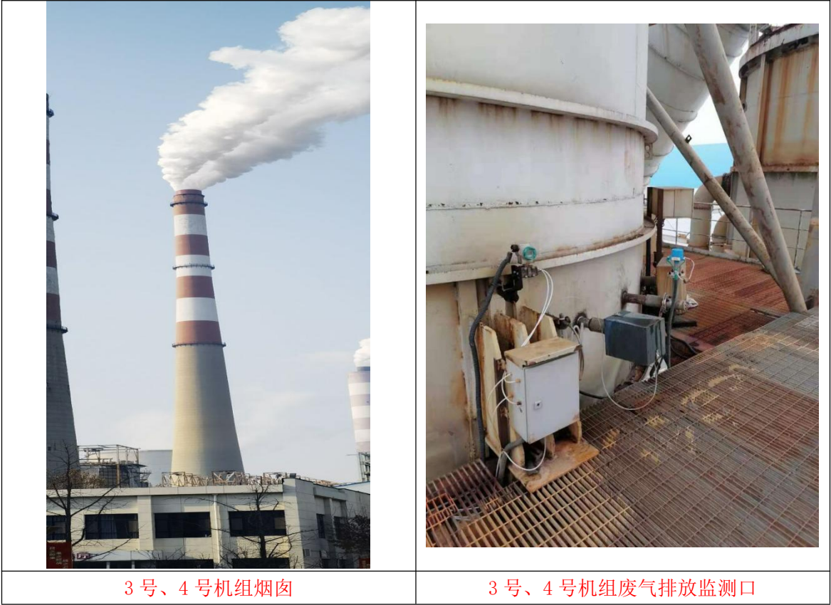
图 2 中国石化集团胜利石油管理局有限公司胜利发电厂废气排气筒监测点位照片
