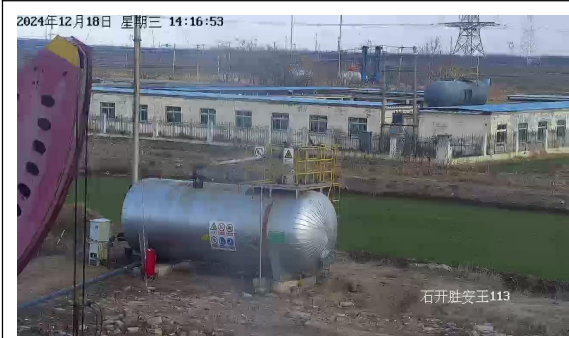
G113 井加热炉 50kW
