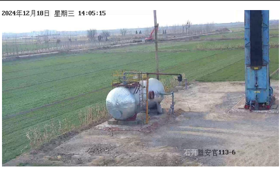
G113-6 加热炉 50kW
