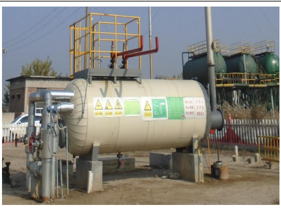
BAE102-X51 井加热炉 200kW
