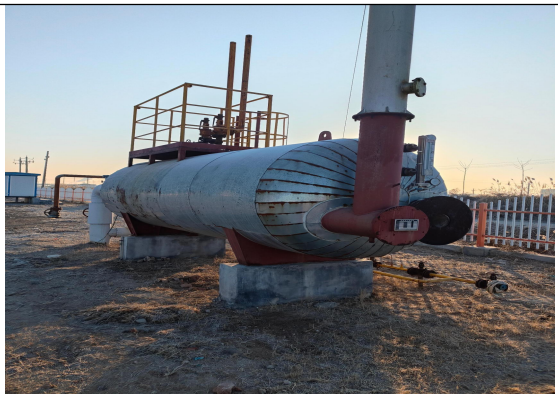
利 93-1#台加热炉 400kW
