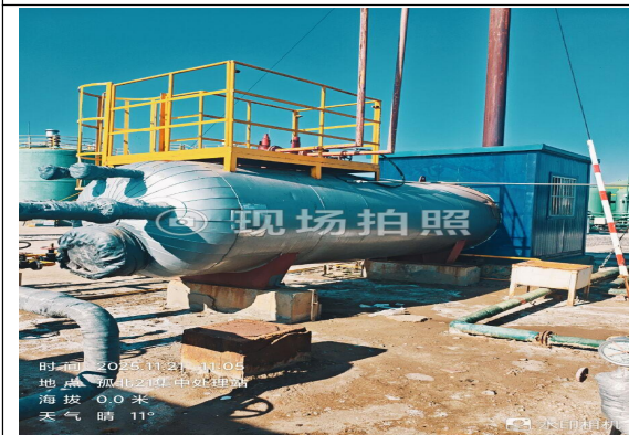
GB21 集中处理站 (1 油加热) 加热炉 230kW
