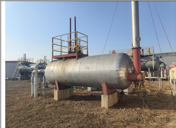
利 38-2#台加热炉 300kW
