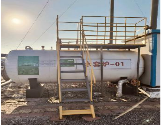
孤南 12 接转站 1 号加热炉 230kW
