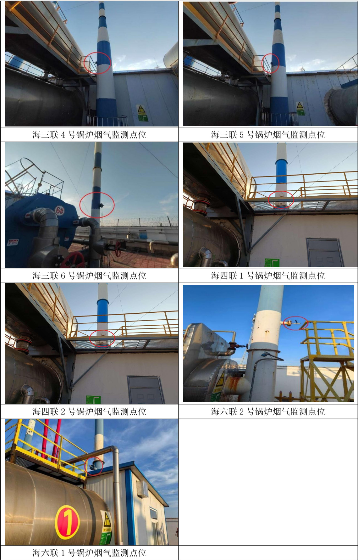
图 1 海洋采油厂排气筒监测点位照片
