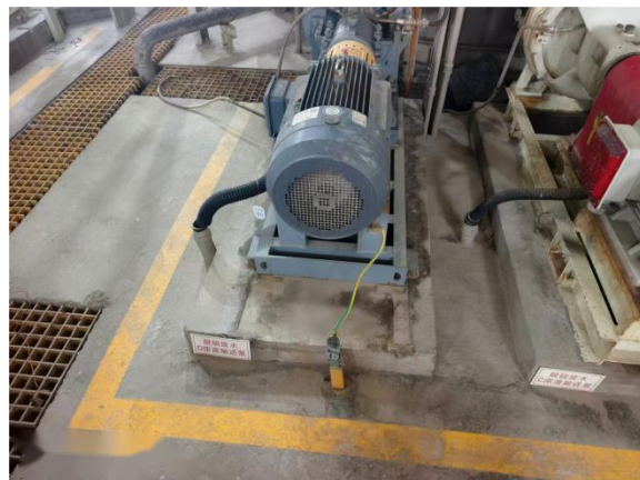
图 2-2 输送泵照片
