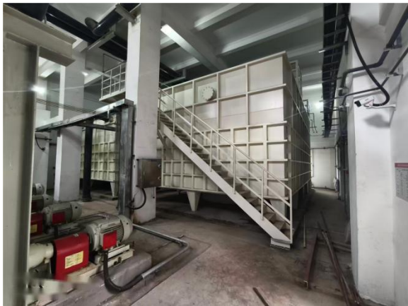
图 2-7 高效絮凝反应斜板沉淀池照片
