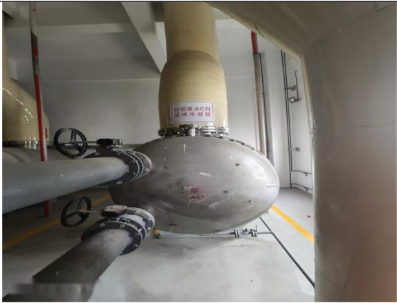
图 2-4 尾端冷凝器照片
