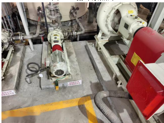
图 2-3 凝结水泵照片
