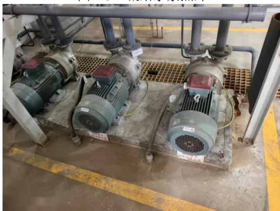
图 2-5 真空泵照片
