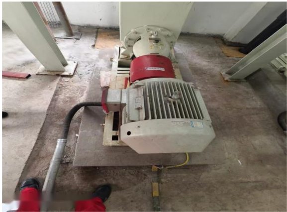
图 2-5 滤前提升泵照片
