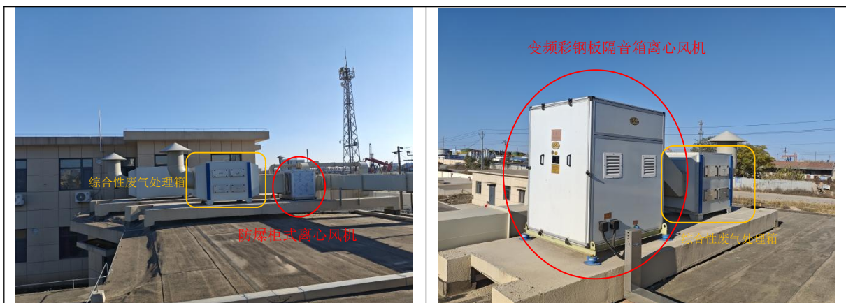
图 2.4-6 本项目新建离心风机及综合性废气处理箱
