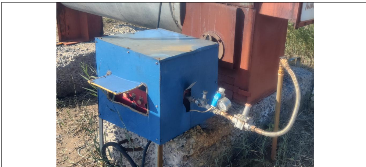
桩23-11-6加热炉低氮燃烧器
