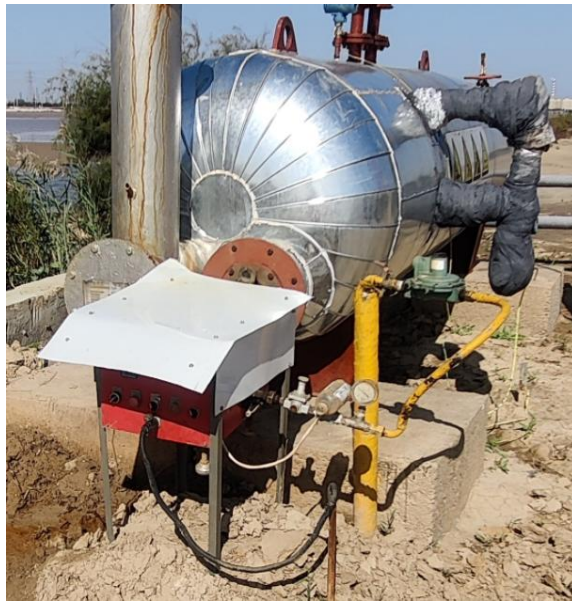
桩23-斜408井场加热炉低氮燃烧器
