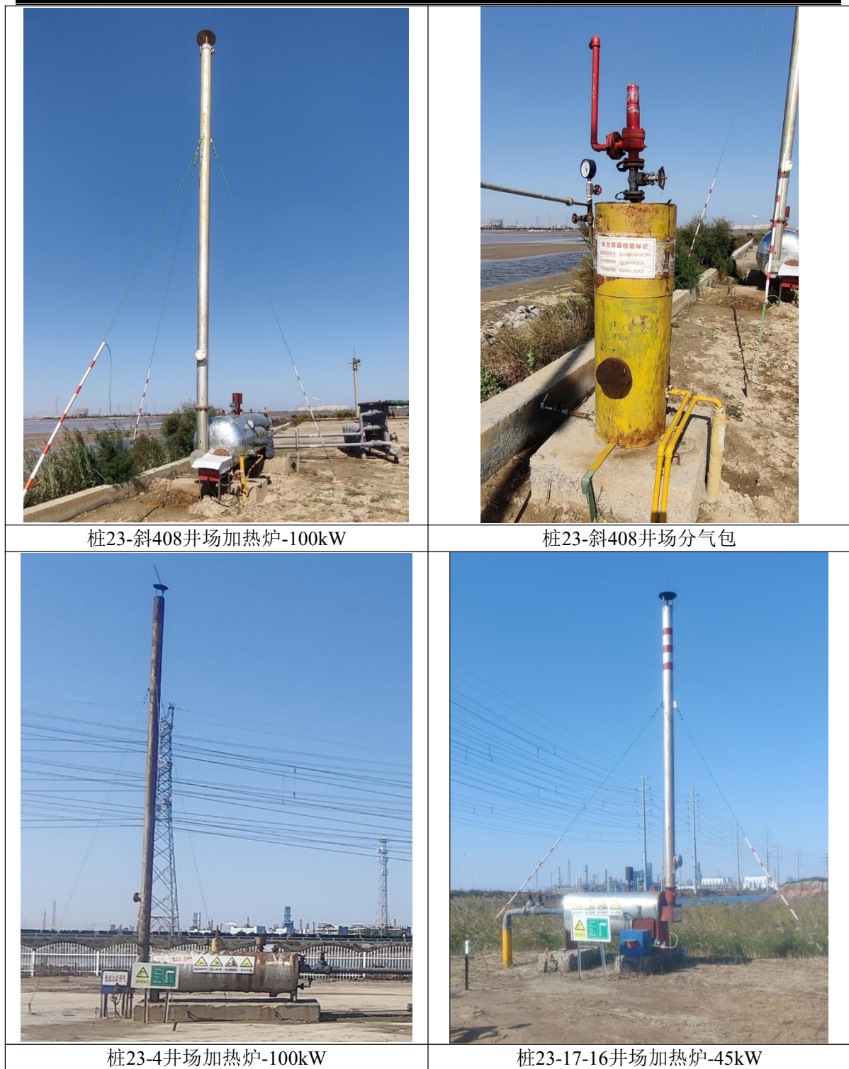
图 3.3-5 加热炉及配套设备现场照片
