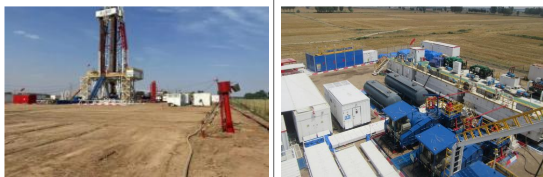
图 2-1 施工期现场照片
