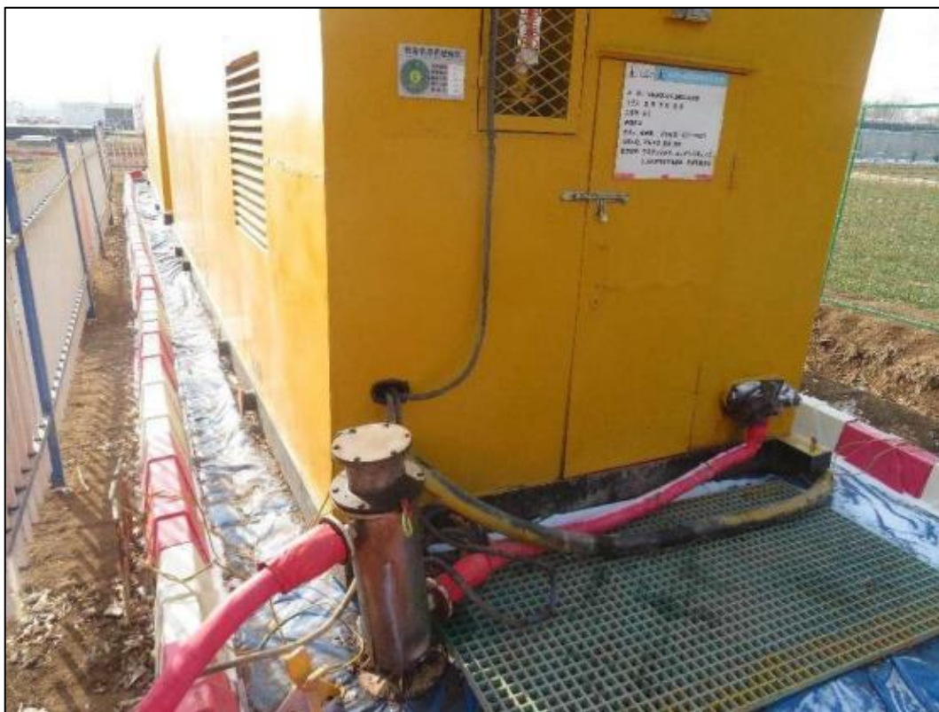
图 4-2 项目防渗措施现场照片
