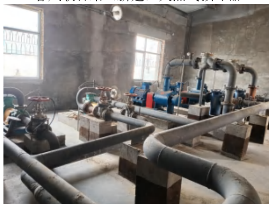
春风联合站（新建）橇装泵房
