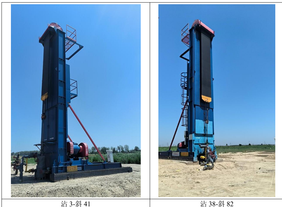
图 3.3-2 项目油井现场照片
