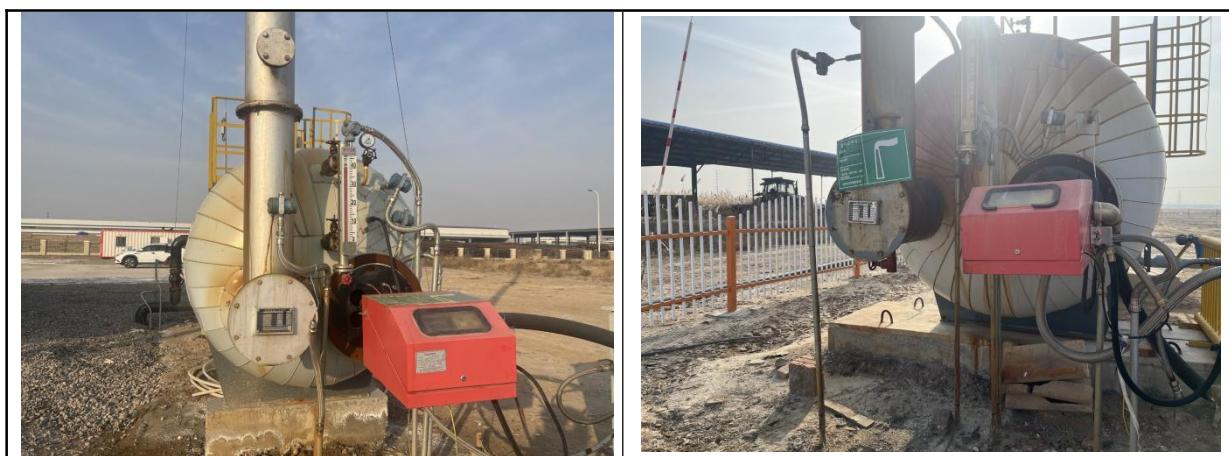
图 5.2-1 本期工程（部分井场）加热炉低氮燃烧器建设情况
