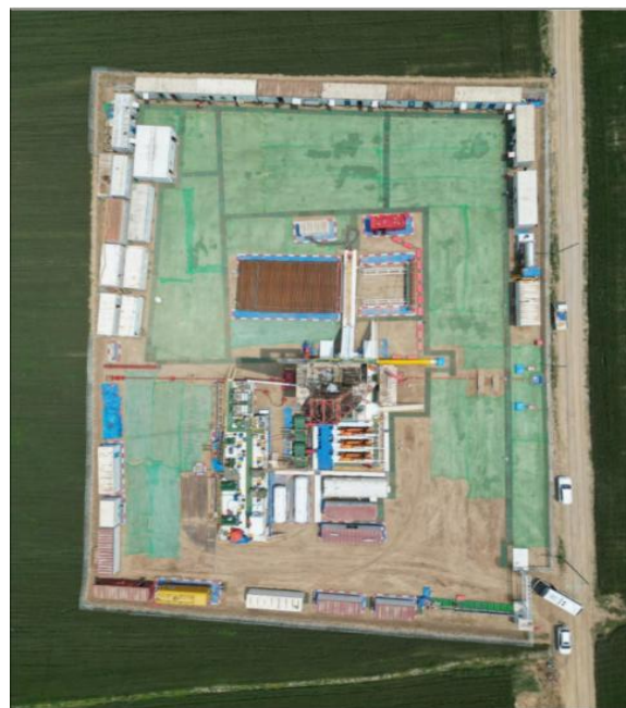
施工期现场照片
