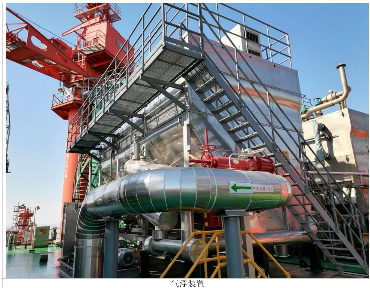
图 3.4-4 中心三号平台采出水处理系统改造现场照片
