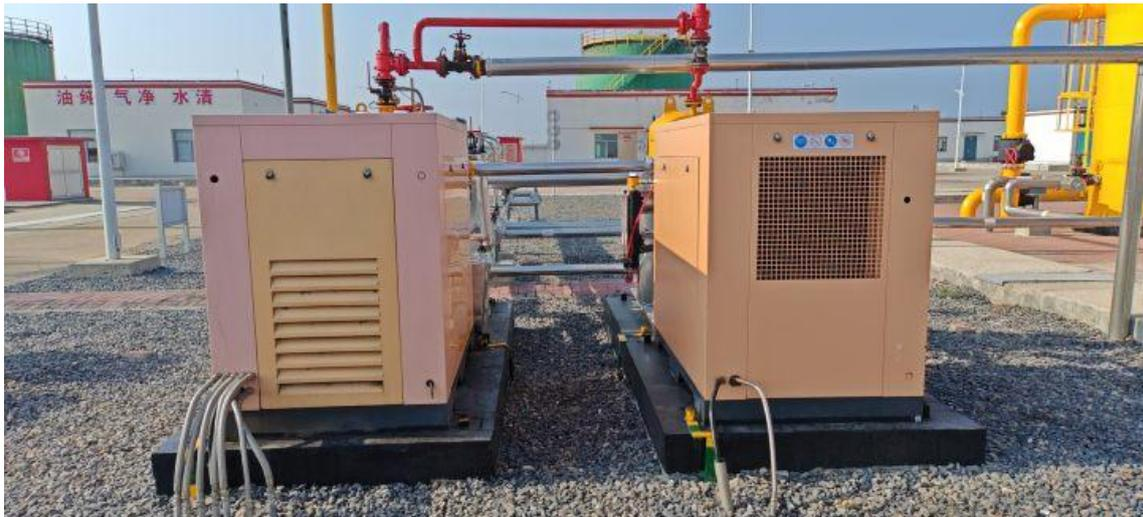
图 4-4 大罐抽气装置现场照片
