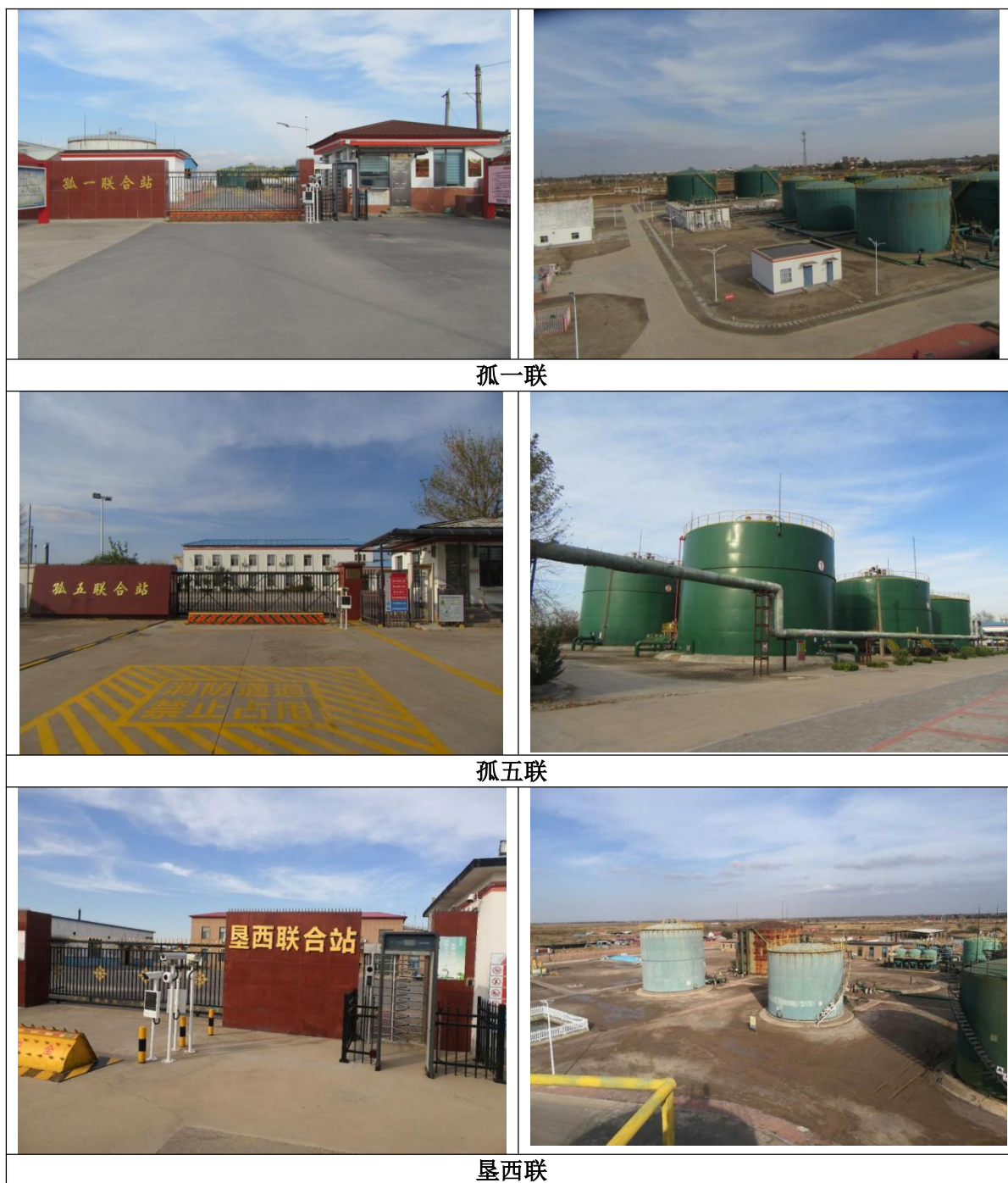
图 3.1-13 依托工程现场照片
