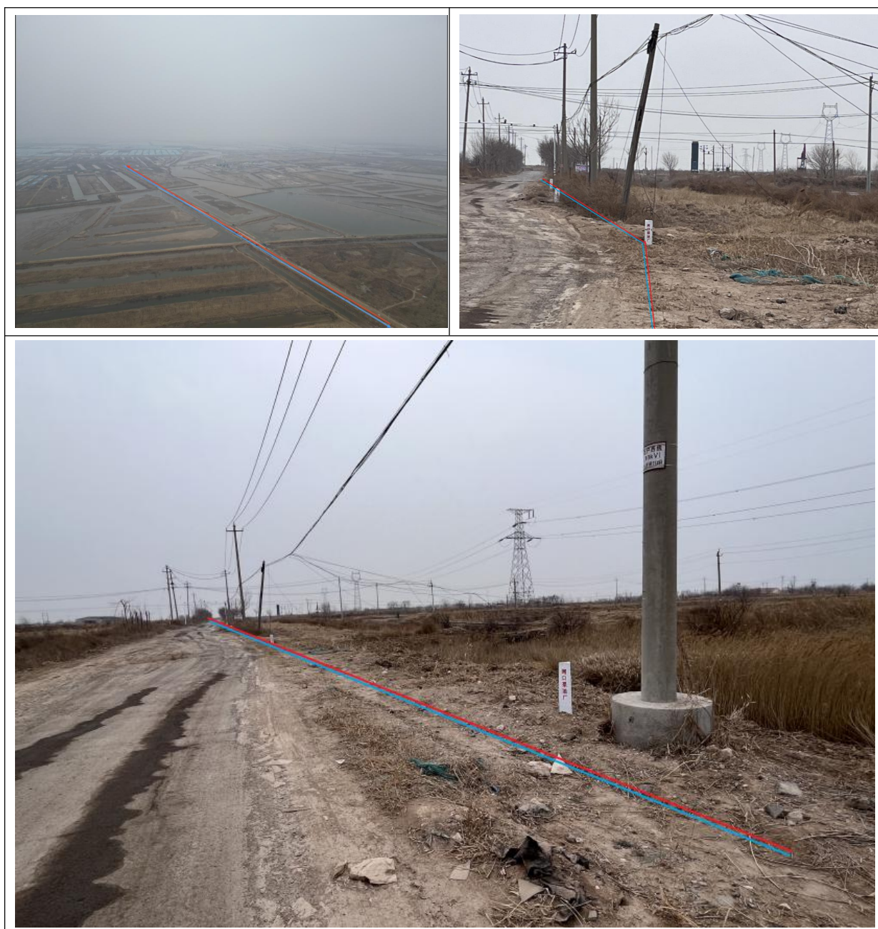
图 5.1-1 管线沿线生态恢复情况照片
