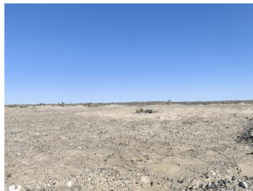
沙12-2井场恢复情况
