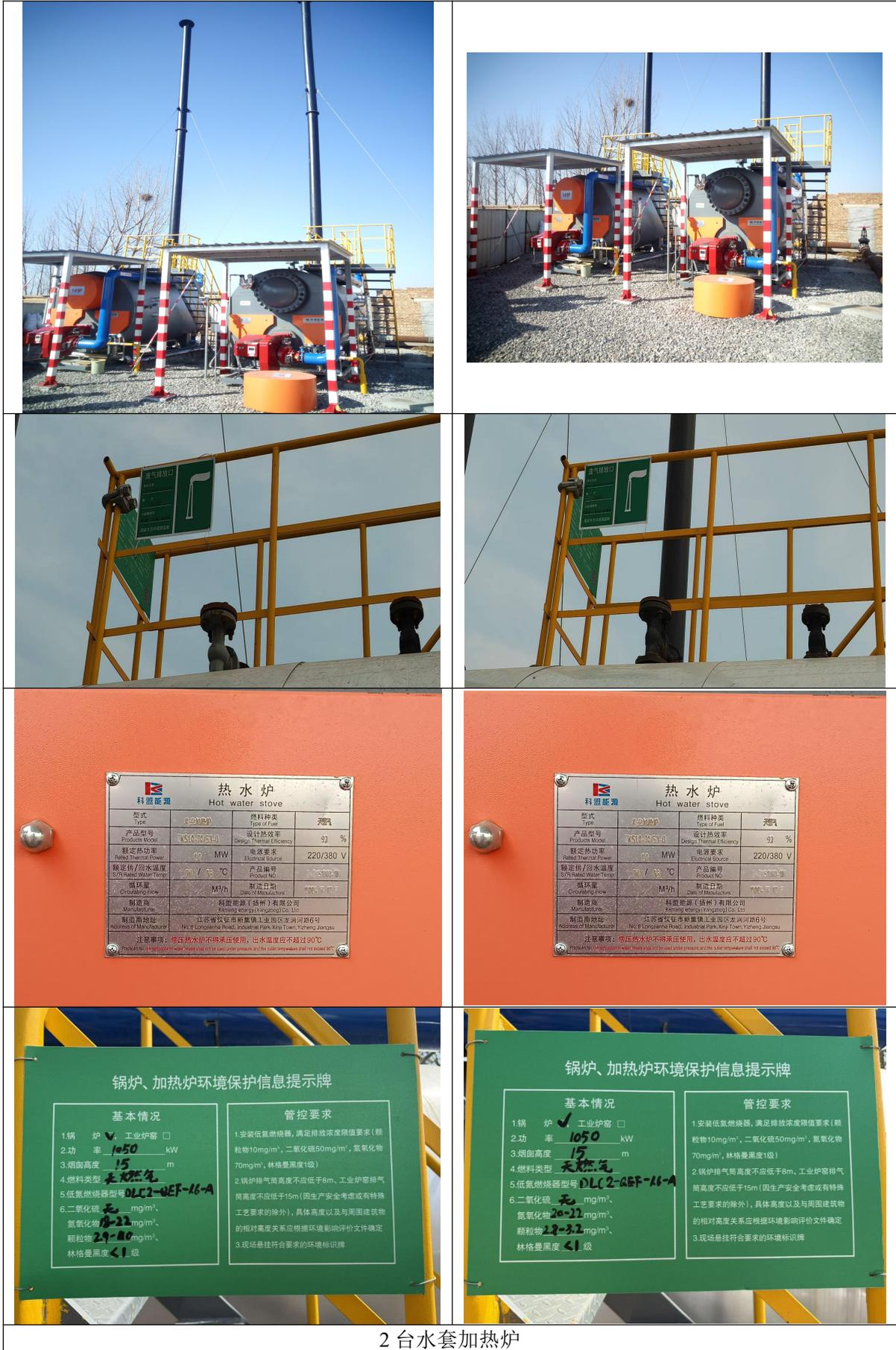
2 台水套加热炉
