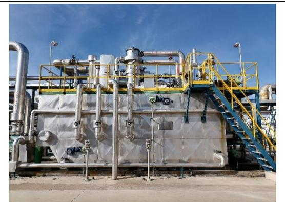
循环水处理系统（油水分离器，位于下层）
