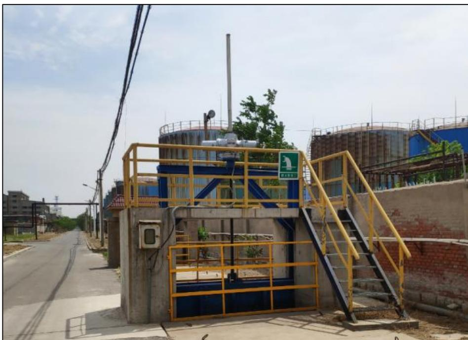
图 4.2-4 厂区雨排口截止阀
