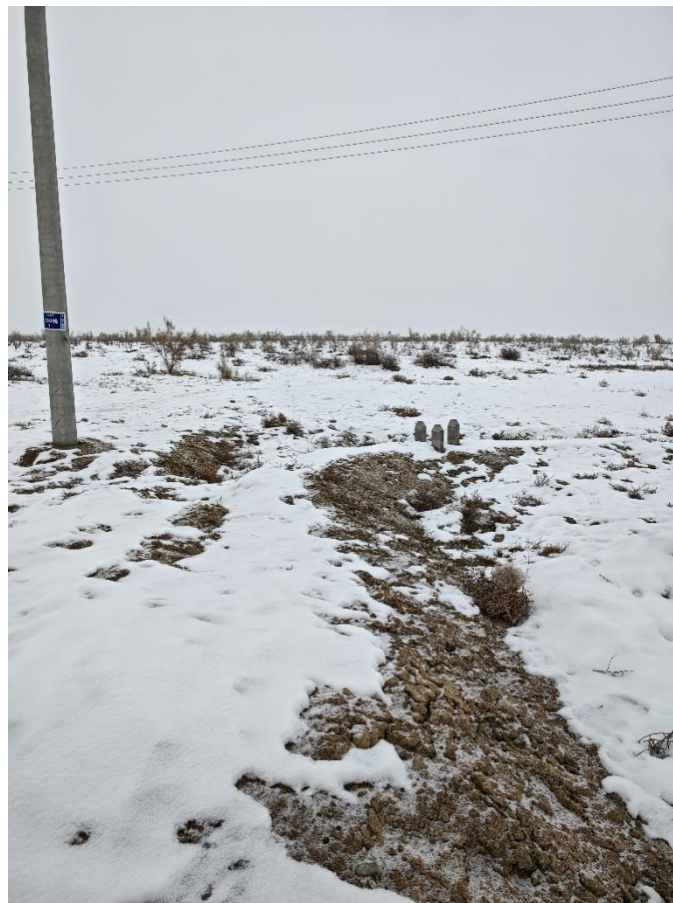
管线沿线临时占地恢复情况
