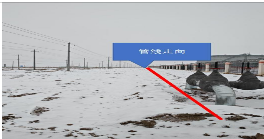
4条更新管线在二号联北侧走向
