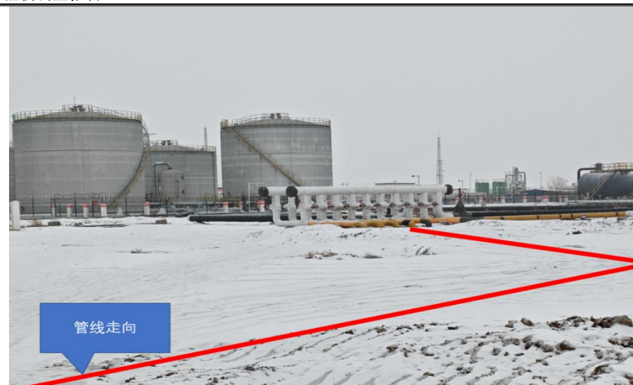
4条更新管线在春风二号联合站站外管线走向
