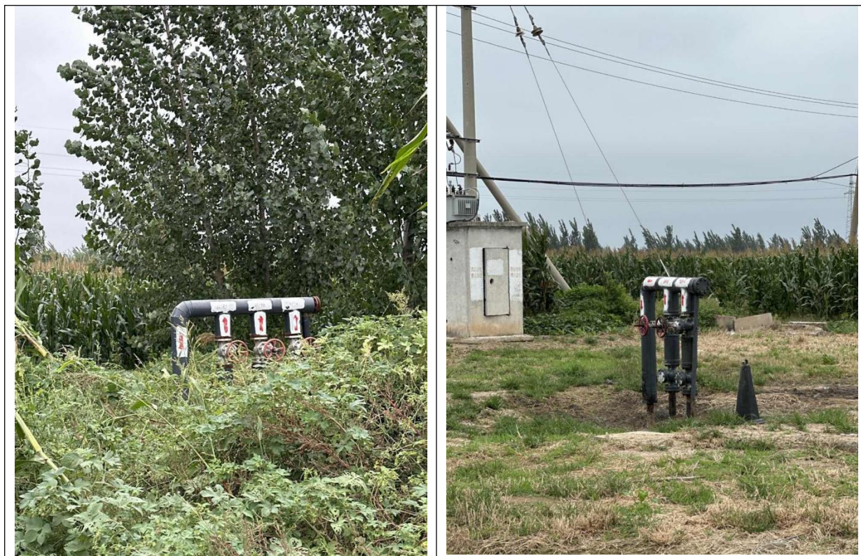
图 3.1-15 管线沿线生态恢复现状现场照片
