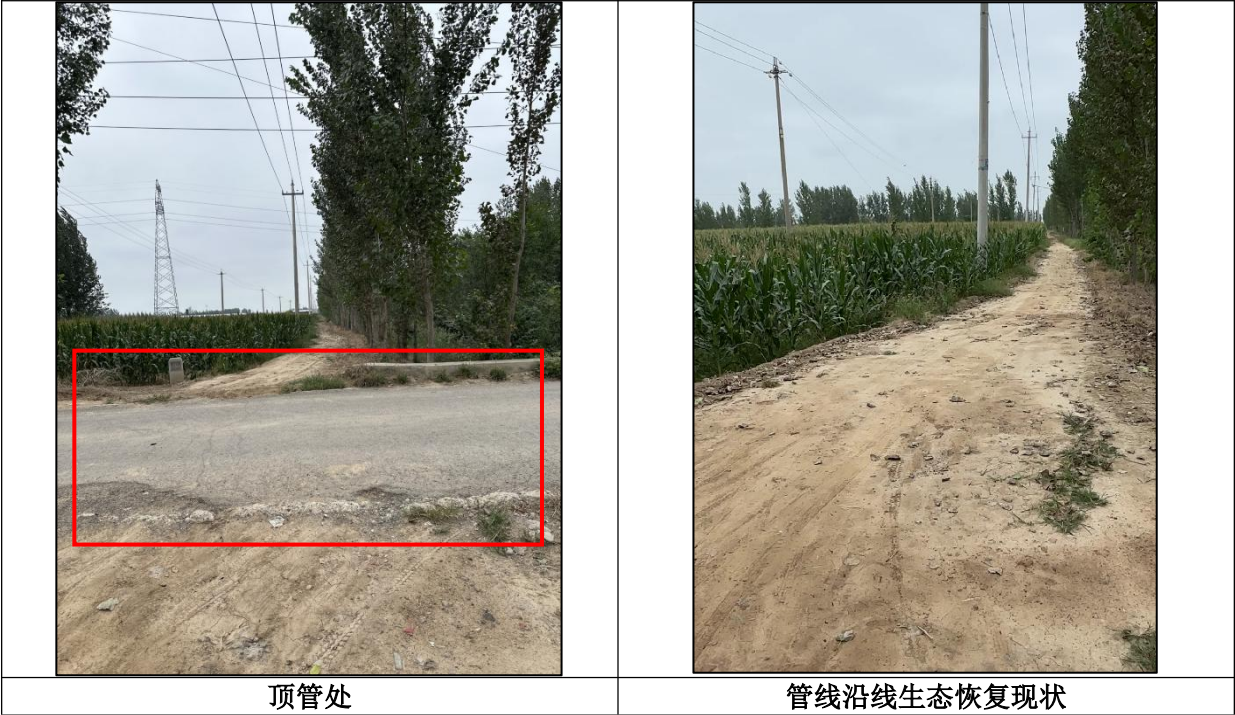
图 3.1-3 管线沿线生态恢复现状照片
